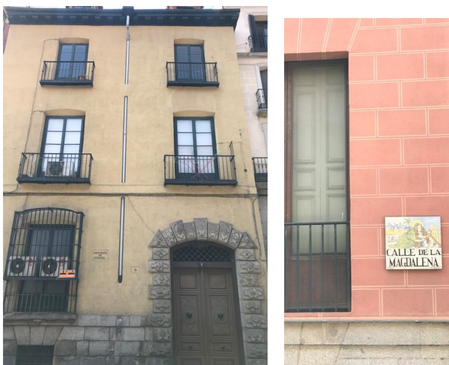
Fig.16. Vista de una de las casas de la calle de la Magdalena, Madrid. 340
