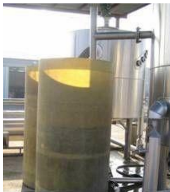
Ilustración 6. Salida del fango de los digestores por rebose
