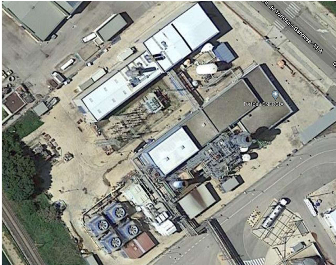
Ilustración 11: Imagen de la central. Fuente: google maps
