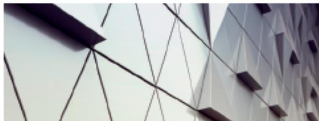
Composite con núcleo de polietileno negro y superficies de aluminio con pintura de poliéster para arquitectura e Industria. El espesor de la hoja de aluminio es de 0,3 mm.
