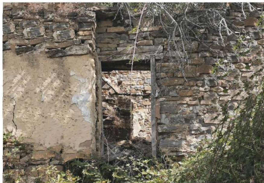
Fig. 168. Hueco de una puerta con carpintería de madera y dintel de madera. Foto: Autor
