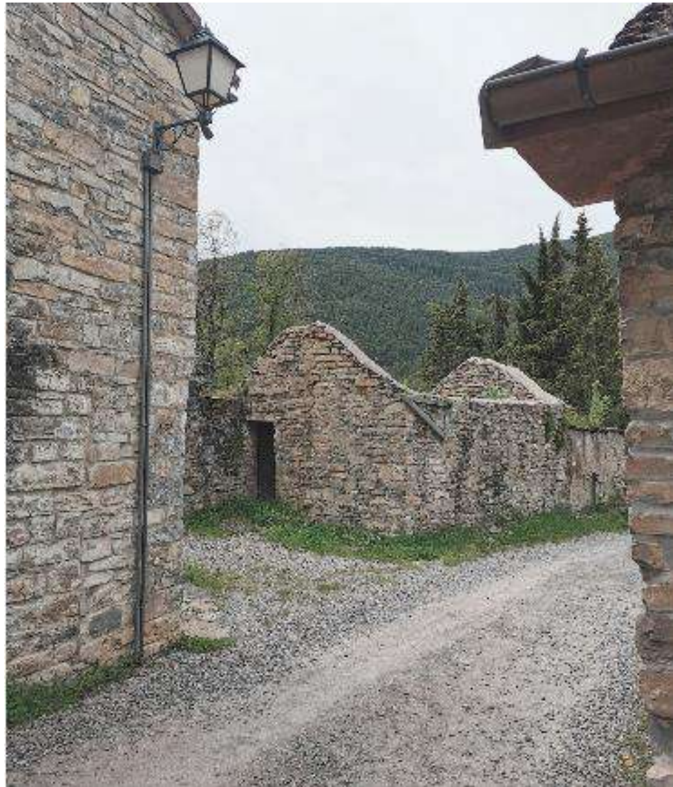
Fig. 275. Edificación en estado de ruina sin su cubierta a dos aguas. Carpintería de madera de la puerta aún presente. Se aprecia al igual que en (Fig.273) una capa de mortero coronando sus muros. Foto: Autor
