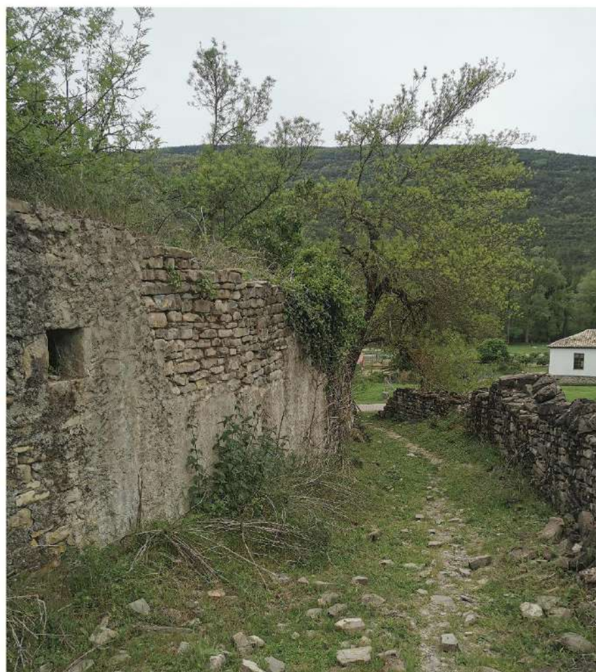
Fig. 191. Camino de ascenso hacia la iglesia. Se aprecia a la derecha un murete de piedra parcelario y a la izquierda otro muro de contención del terreno y el arranque de una edificación con un hueco simple. Foto: Autor
