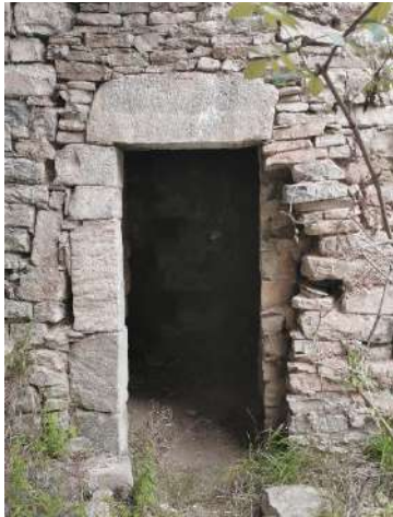
Fig. 33. Puerta de madera con dintel de bloque de piedra en una edificación en Acín. Foto: Autor
