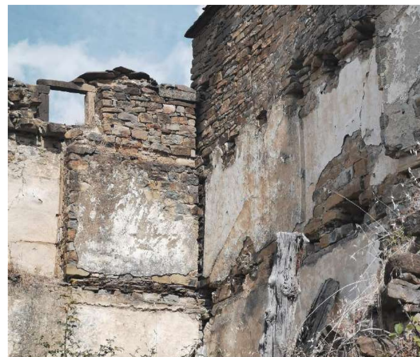
Fig. 170. Detalle de los huecos en el muro donde se apoyaba el forjado de las distintas plantas de la edificación. Foto: Autor
