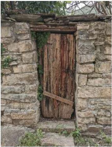
Fig. 33. Puerta de madera con dintel de bloque de piedra en una edificación en Acín. Foto: Autor
