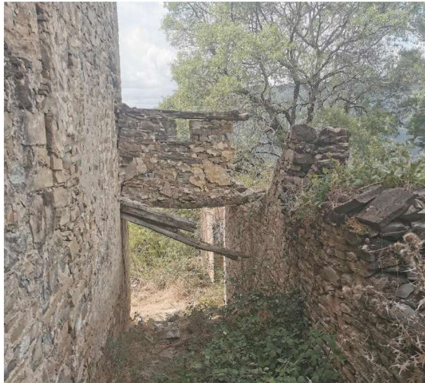
Fig. 176. Continuación del callejón que conecta con la Calle Baja. Se aprecia un paso bajo un volumen que conectaba ambas edificaciones. Se encuentra en un estado de ruina avanzada y se aprecia un hueco en él y el forjado de madera descolgado. Foto: Autor
