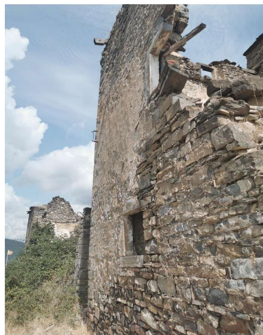
Fig. 167. Fachada de una edificación en la Calle Baja donde se aprecian los huecos con su sistema constructivo de piezas monolíticas de piedra formando el dintel, la jamba y el alfeizar. Foto: Autor
