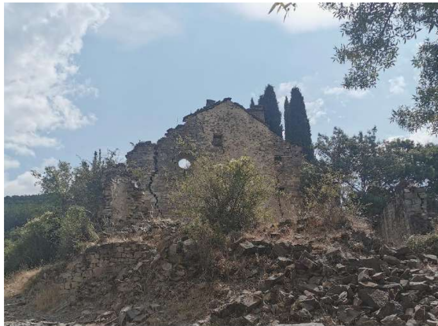
Fig. 164. Alzado de la iglesia de Bergosa con rasgos de derrumbe en su fachada. Foto: Autor
