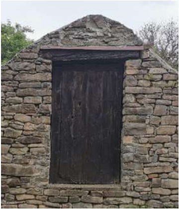
Fig. 38. Puerta de madera con dintel de madera en una edificación en Villanovilla. Foto: Autor
