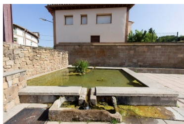
[FIG.46] Lavadero de Abiego
