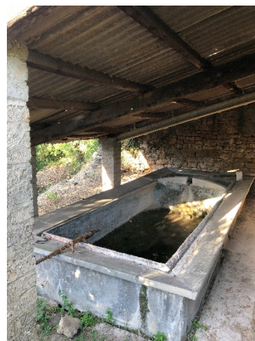
[FIG.45] Lavadero de Colungo
