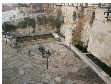
[FIG.48] Lavadero de la Hoz de Barbastro
