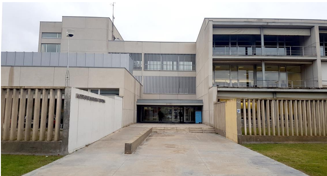
Ilustración 6: Fotografía exterior acceso sur al edificio Lorenzo Normante. Fuente: Elaboración propia
