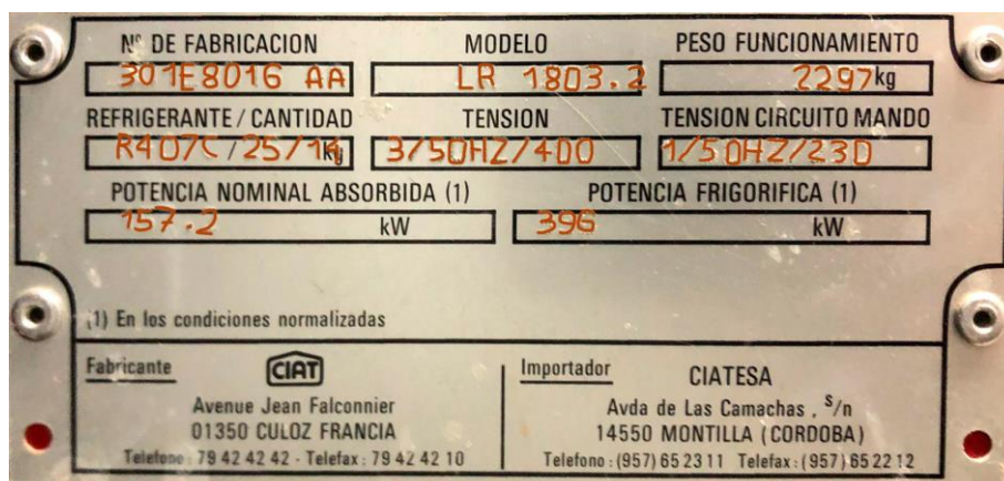
Ilustración 86: Placa de características de la bomba de calor CIAT, modelo LR-1803.2.
