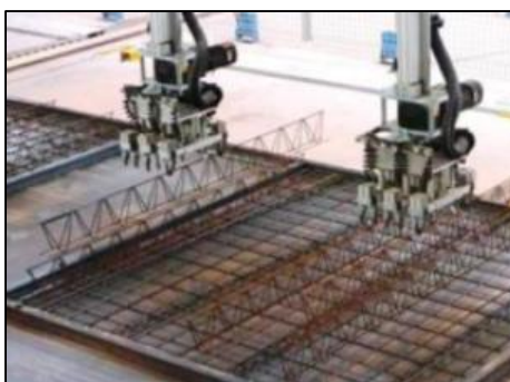
6 Colocación de armadura en el panel.
