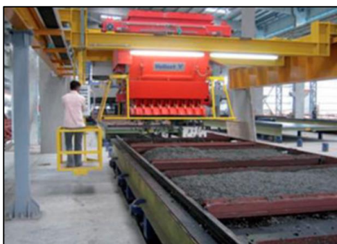
5. Inyección del hormigón en los moldes.
