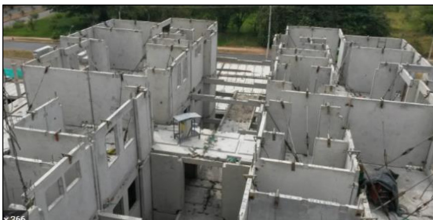
4. Edificio construido con paneles prefabricados.
