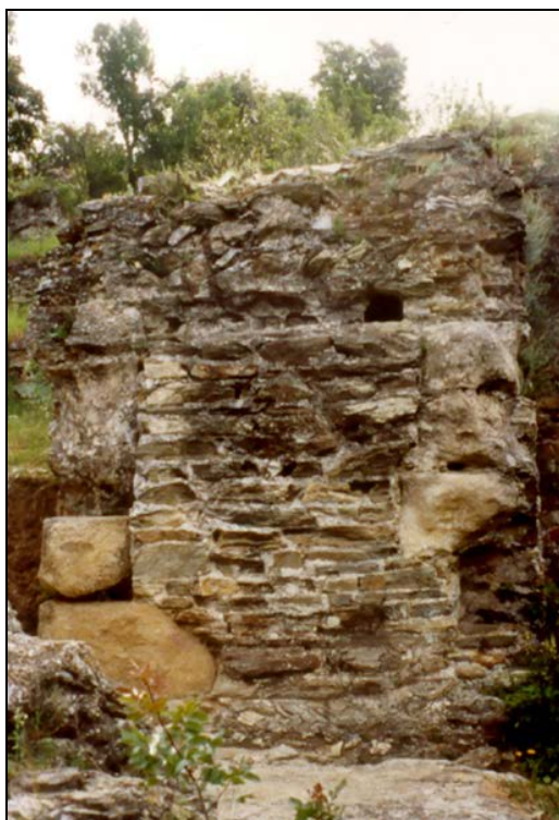
Vista de los bloques reaprovechados en la poterna. Imagen a partir del catálogo AdIF .
