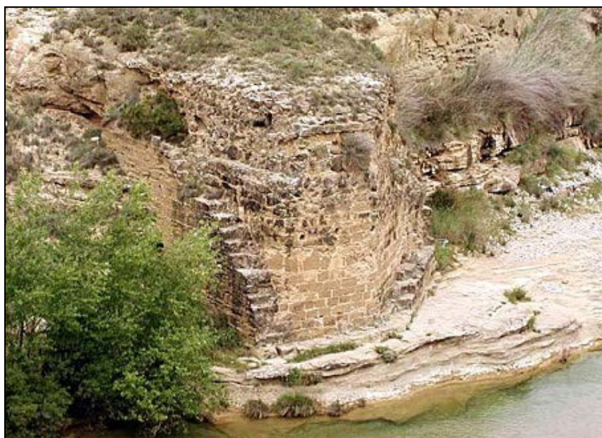
Restos actuales del estribo derecho del puente romano. 2
