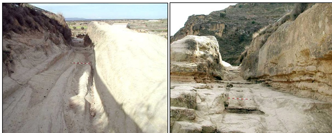
Calzada excavada en la roca a su salida de Pertusa con marcas de rodadas. 1
