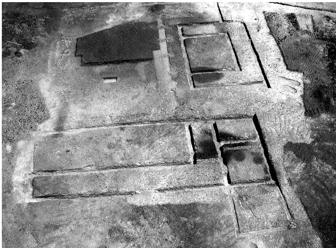
Fig. 44 B: Vista aérea del mismo edificio. (Núñez y Sáenz 2005).
