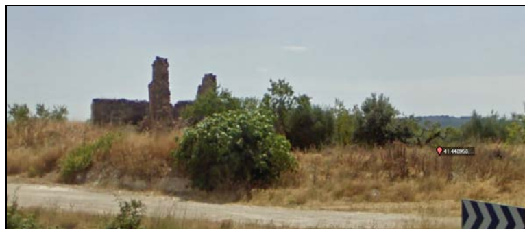
Restos de la edificación del Hostal de la Manxa desde la N-240.
