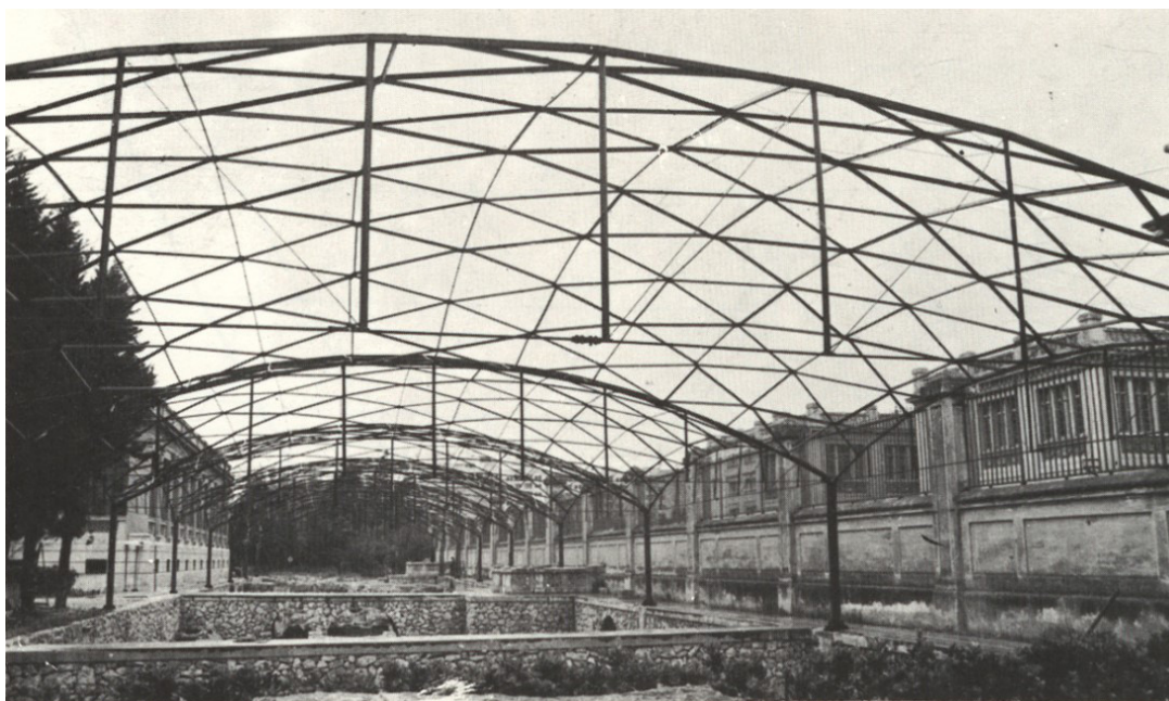
Fig. 158. Cubierta para proteger las excavaciones arqueológicas de la necrópolis paleocristiana de Tarragona. Fuente: Revista Arquitectura , n.163-164, julio-agosto 1972.
