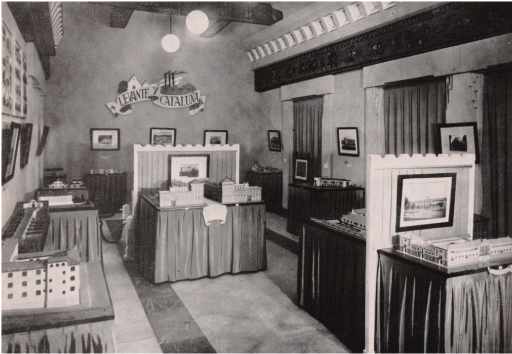
Fig. 49. Vista parcial de la Sala dedicada a la zona de Levante y Cataluña. Fuente: Revista Reconstrucción , n. 87, noviembre-diciembre 1948.
