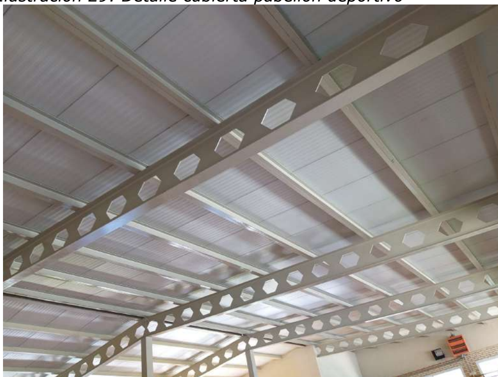
Ilustración 29: Detalle cubierta pabellón deportivo
