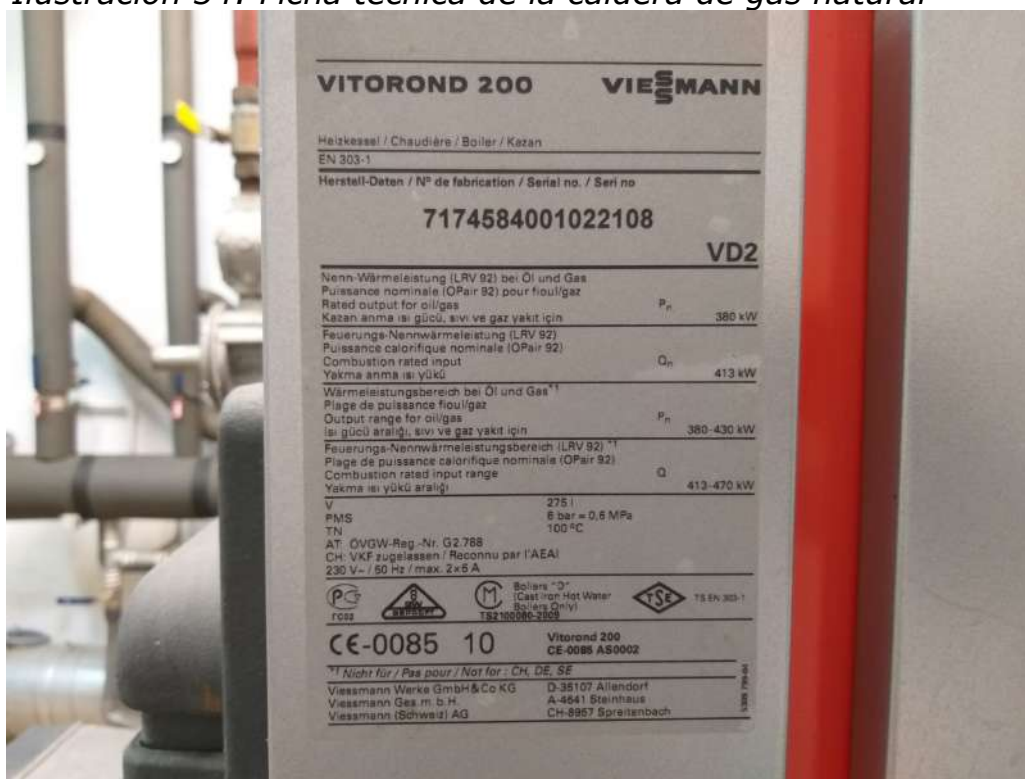
Ilustración 34: Ficha técnica de la caldera de gas natural
