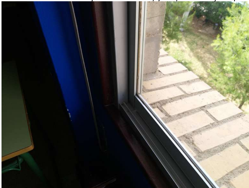
Ilustración 21: Detalle puente térmico, pilar, alféizar y carpintería.
