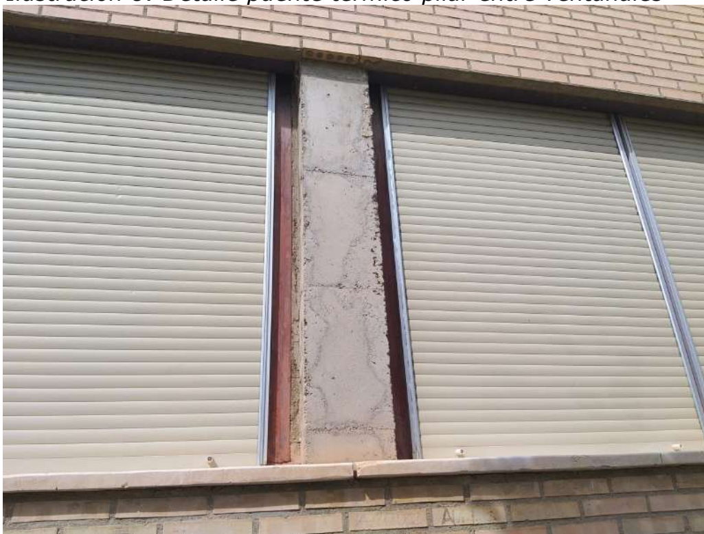
Ilustración 8: Detalle puente térmico pilar entre ventanales
