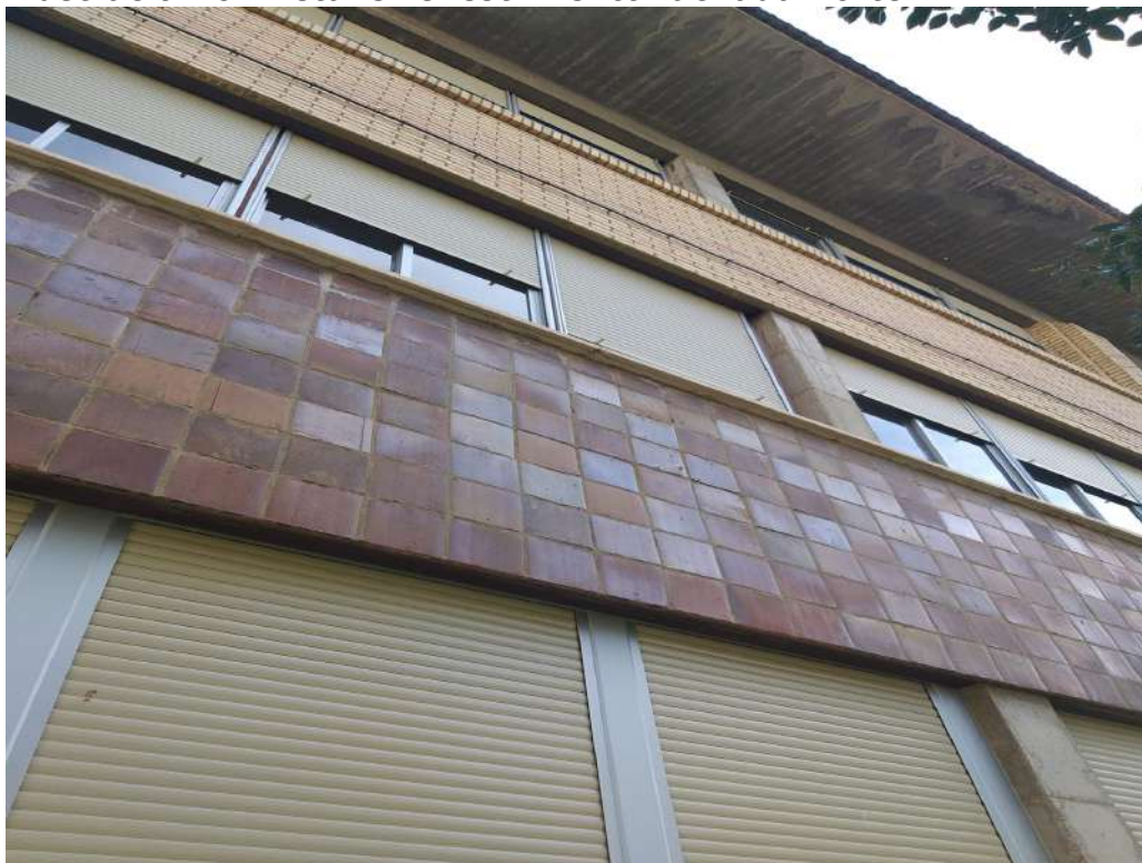
Ilustración 6: Detalle revestimiento fachada norte
