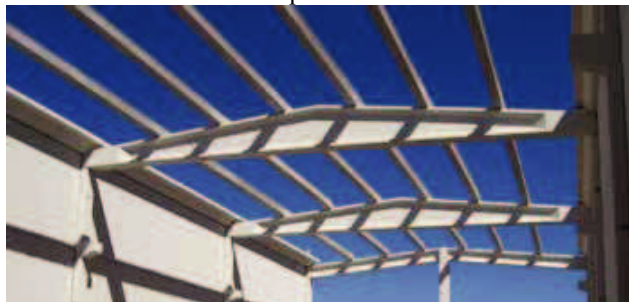
FIGURA III. Disposición de las correas.
