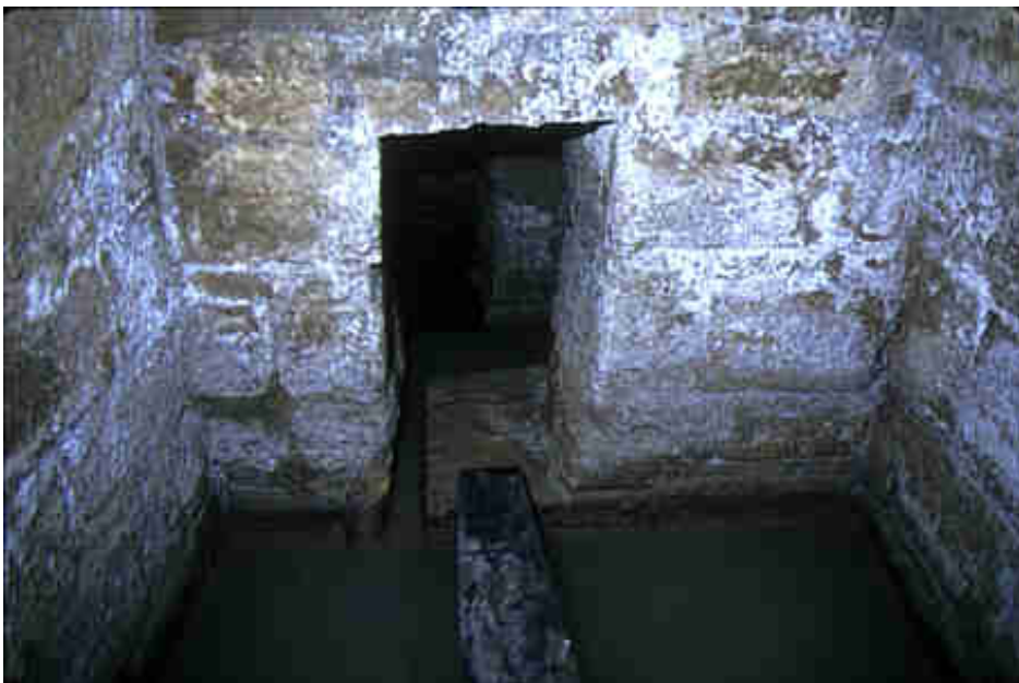
Cisterna y acceso galería de captación de la Fuente Madre Obtenido de Turismo Los Monegros
