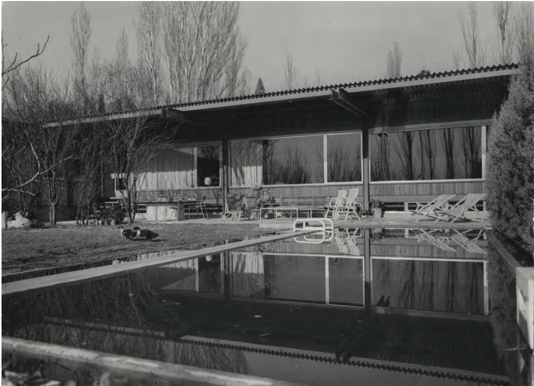
VIVIENDA PUERTA DE HIERRO II, 1961. MADRID
