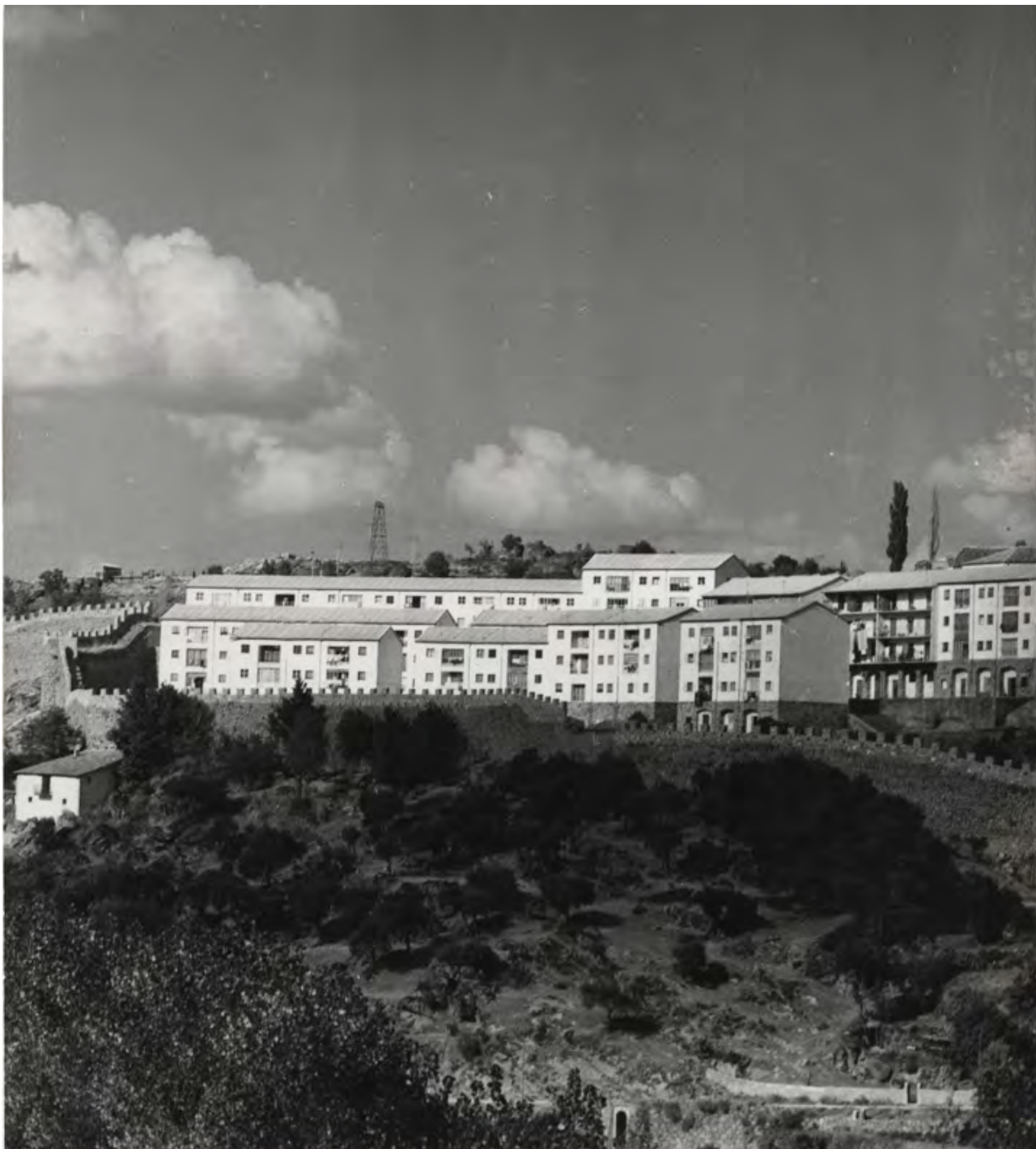
Fig. 5. 1942. Viviendas Santa María de las Huertas en Béjar (Salamanca). AFC Francisco Cabrero - Desconocido
