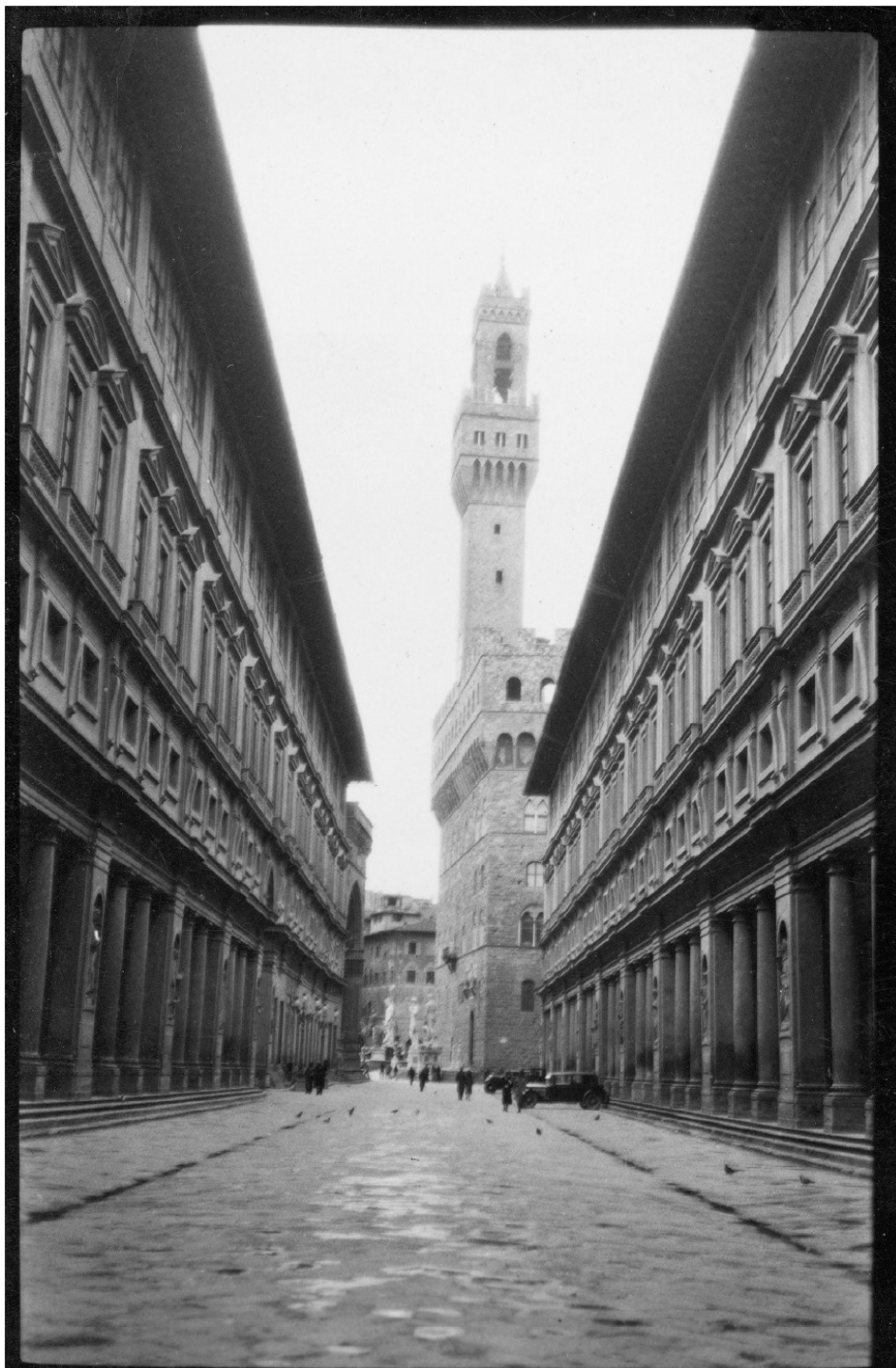
Fig. 46. 1948. Galería Uffizi y Palacio Vecchio. Florencia. Francisco Cabrero
