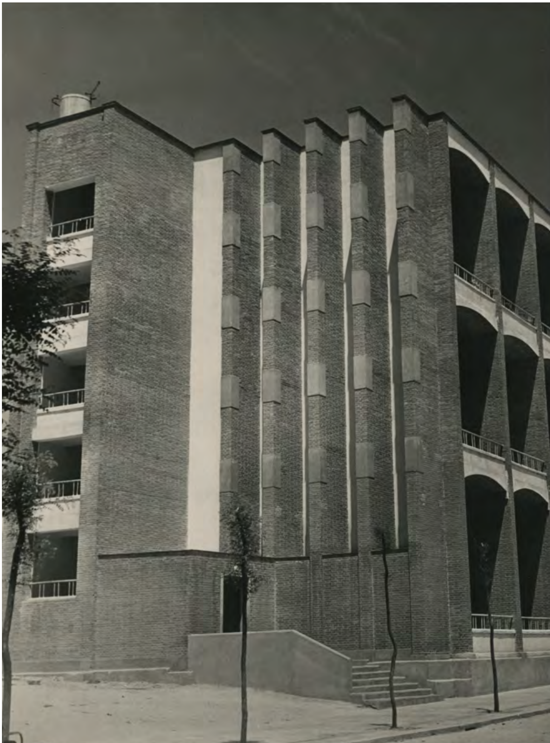
Fig. 14. 1949. Bloque de viviendas Virgen del Pilar. AFC Francisco Cabrero - Kindel
