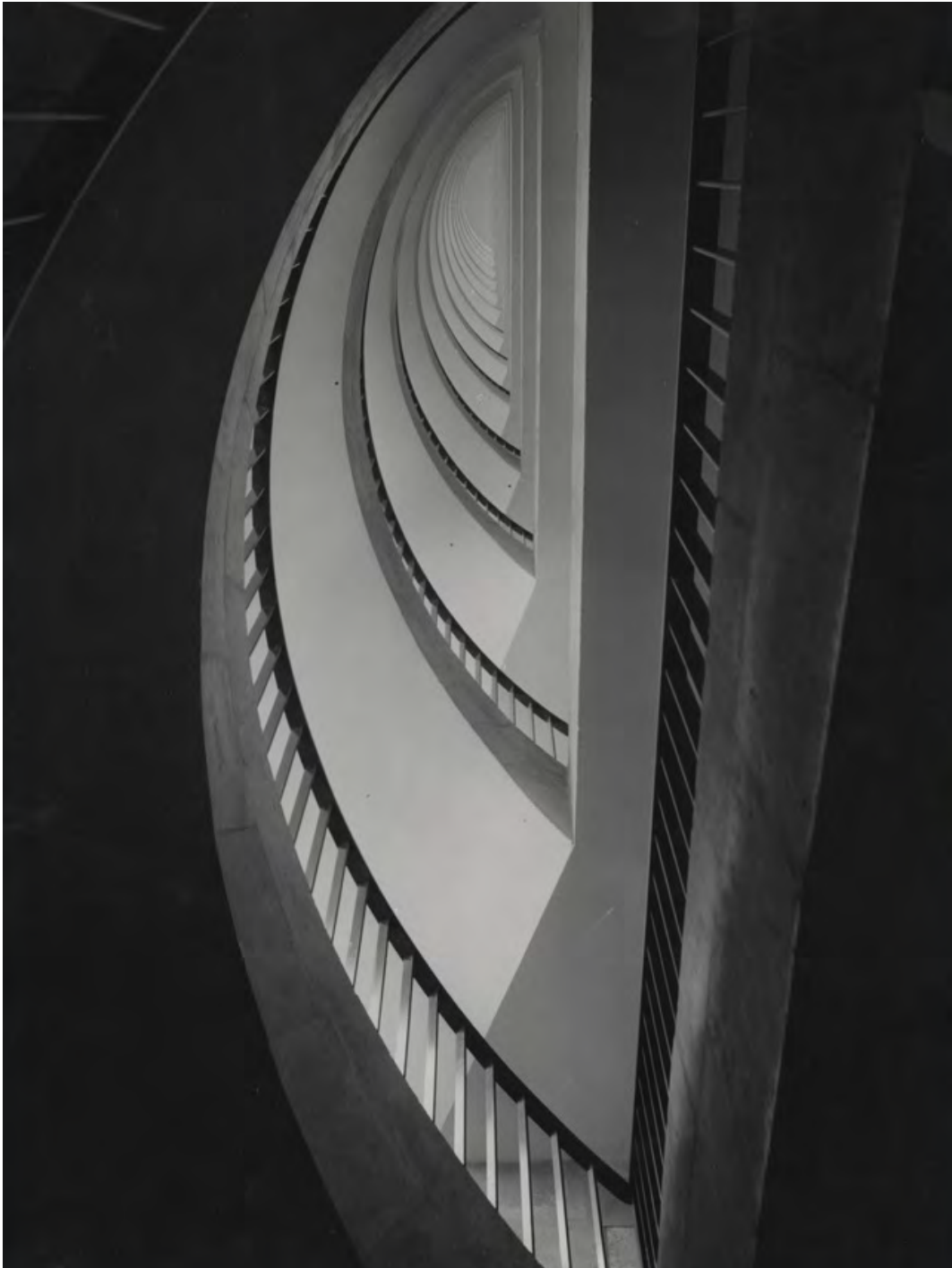
ESCALERAS DE LA CASA SINDICAL, 1949. MADRID
