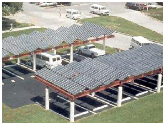
Figura 30: Marquesina sin inclinación con placas con inclinación
