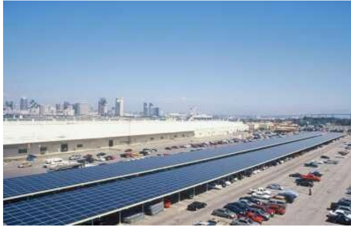
Figura 29: Marquesina sin inclinación con placas solapadas
