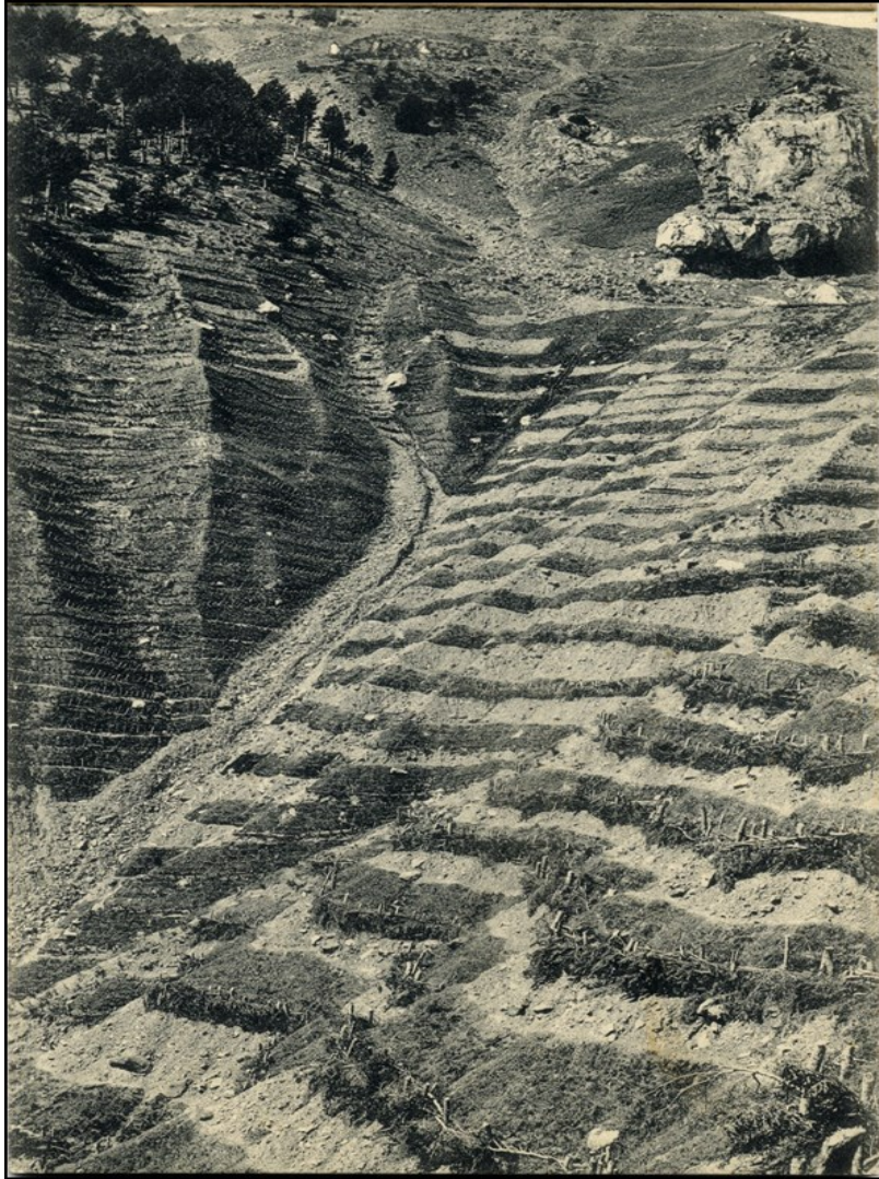
Fig. 89. Ladera de gran inclinación encespedada con placas trasplantadas y fijadas mediante estacas de madera. Foto: Lasheras, col. José Coarasa. Se procuró encespedar el monte en las zonas más descarnadas, trasplantando placas de césped arrancadas en losas de 20 x 60 x 20 cm, que eran extraídas de los pastizales cercanos, ante la oposición de los ganaderos, para los que se impuso coto en los montes no sin grandes protestas.
