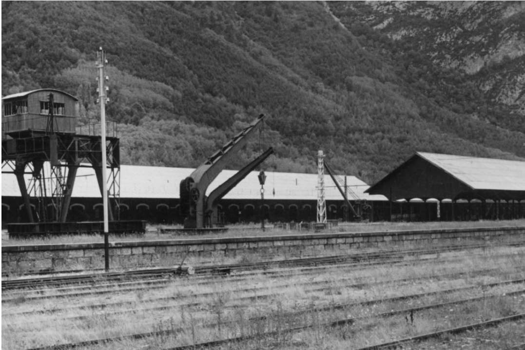
Fig. 146. Grúas dinámicas en los muelles intermedios de baja velocidad, diseñadas por Eugenio Grasset en 1929. Foto: FFE.
