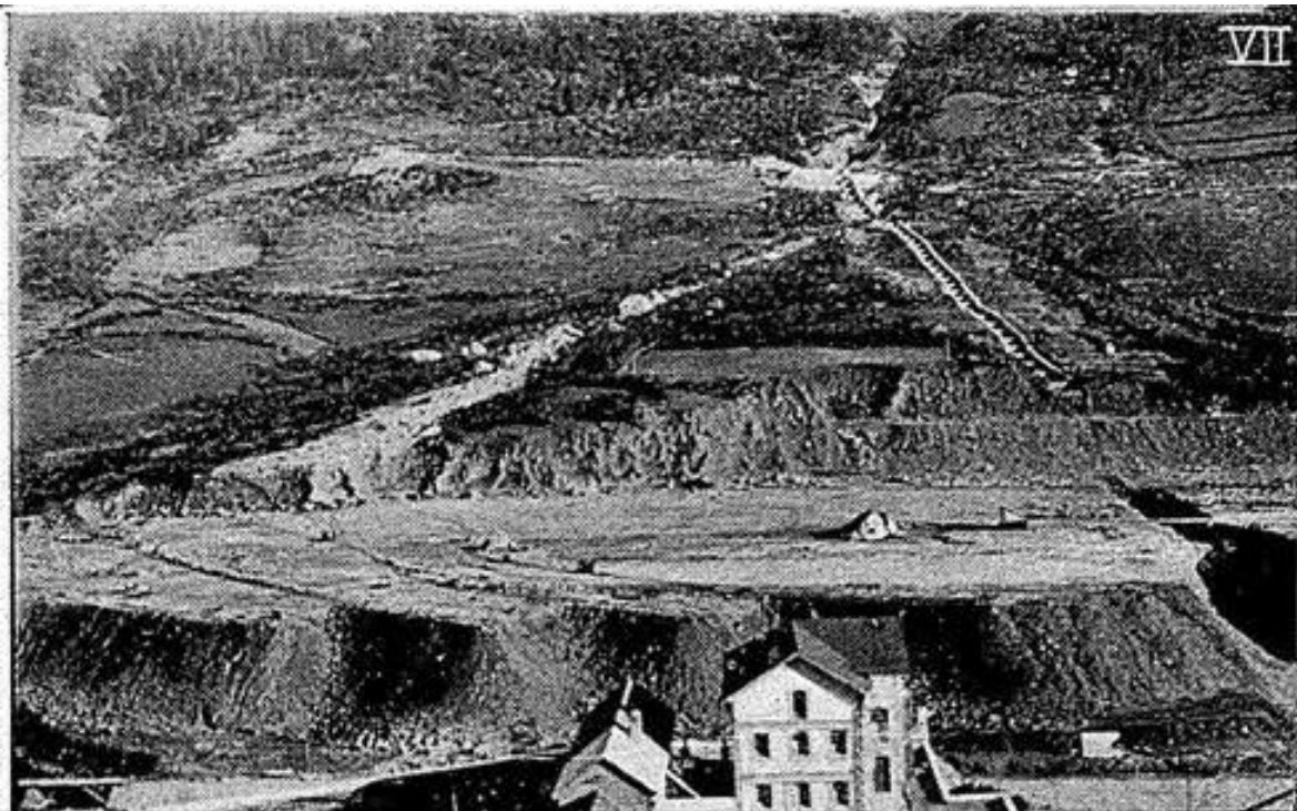
Fig. 97. Imagen de la situación de la explanada de Arañones en verano de 1918. Los rellenos provenientes de la perforación del túnel y de la excavación de la montaña se habían vertido sobre el cauce del río sin estar realizados todavía los cimientos del Edificio de Servicio, ya que no se había fijado su posición exacta en la explanada. Imagen extraída de la revista Ibérica, Tortosa, Observatorio del Ebro, n° 259 - 60, 11 - I - 1919, p. 23.
