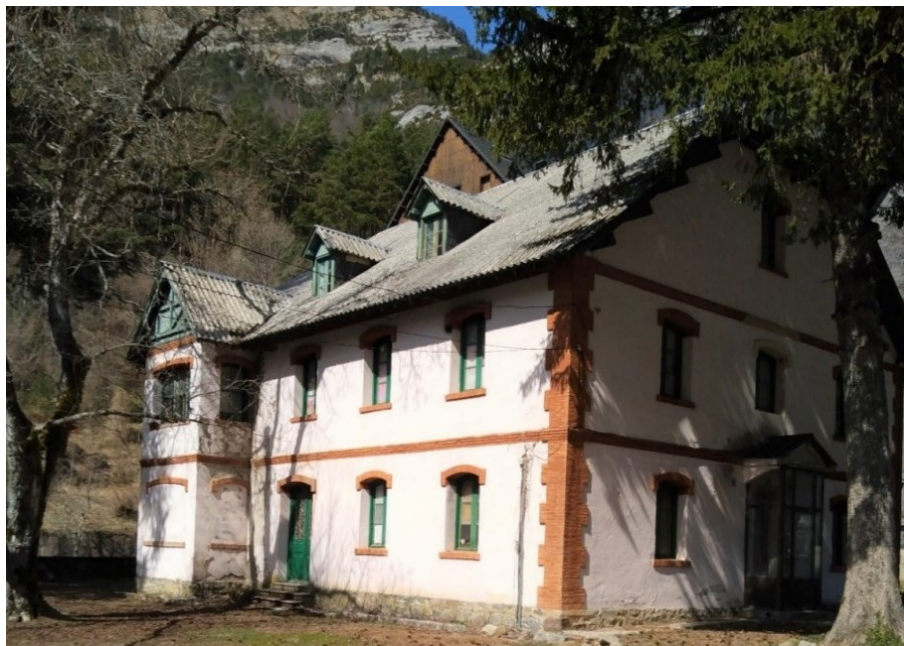
Fig. 259. Aspecto actual de la casa del Estado nº 1, tras algunas reformas. Foto: Belén Domínguez.
