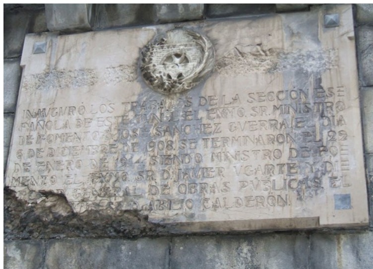
Fig. 78. Placa conmemorativa de la culminación del túnel ferroviario de Somport. La placa fue mutilada, probablemente en época de la Segunda República, pues solo fue repicada la inscripción de la parte superior que hacía referencia al monarca Alfonso XIII. Foto del autor.
