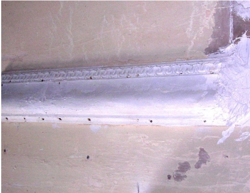
Fig. 203. Sistema de fijación de las molduras del vestíbulo mediante clavos de hierro todavía visibles. Foto del autor.
