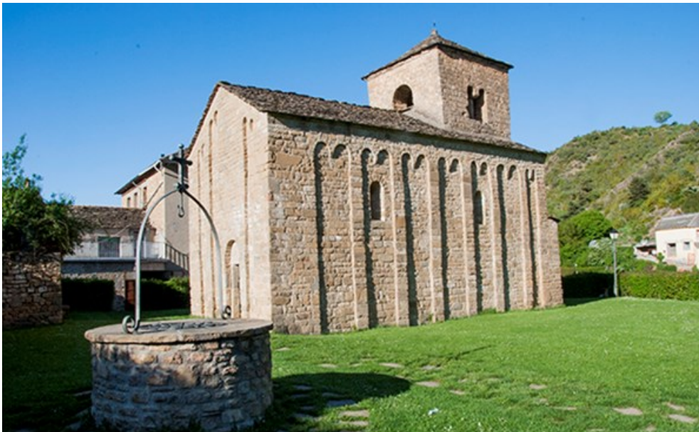
Figs. 304 y 305. Imagen superior. Central hidroeléctrica de Ip c.1968. Proyecto de Conrado Sancho Rebollida y Miguel Fisac. Foto: Fundación Miguel Fisac. Imagen inferior Iglesia de San Caprasio en Santa Cruz de la Serós (Huesca). Esta pequeña ermita de estilo románico lombardo restaurada en los años cincuenta del siglo XX, por el arquitecto Fernando Chueca Goitia, dista apenas 30 km de Canfranc-Estación. Foto del autor.
