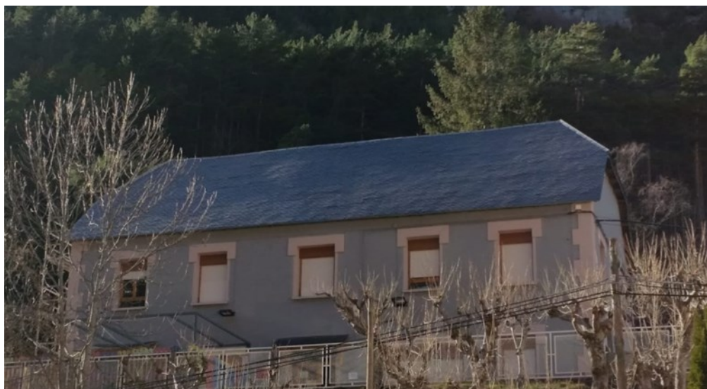
Fig. 280. Antiguo hospital en su estado actual, transformado en una ludoteca municipal. Foto: David Ibáñez.
