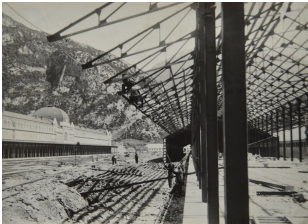
Fig. 143. Operarios de Zaragoza Industrial S.A. trabajando en las cubiertas de los muelles de baja velocidad. Fotografía desconocido, hacia el verano de 1926. Colección Alonso Robisco.
