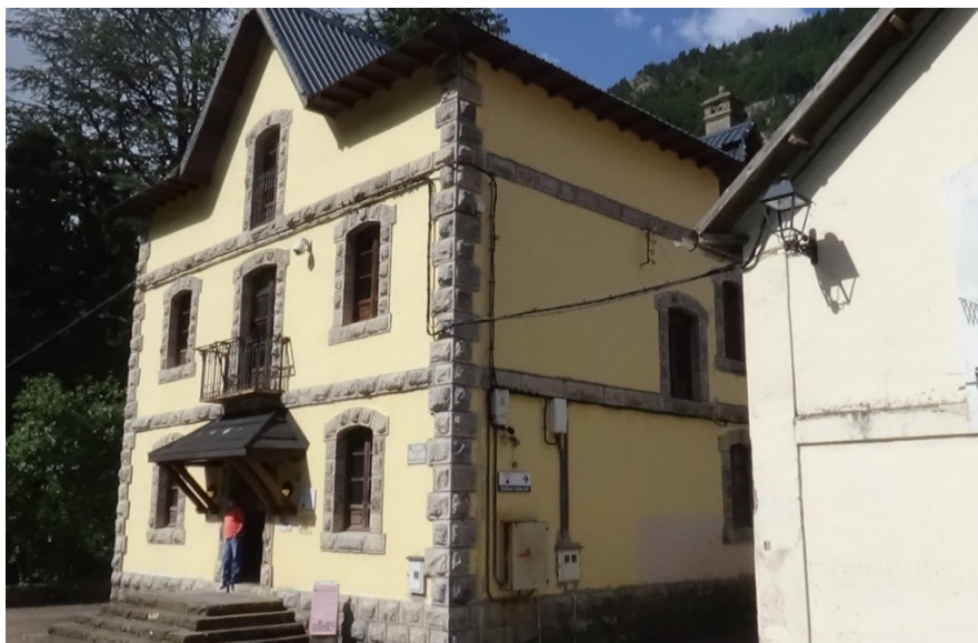
Fig. 265. Casa de los Forestales en Canfranc-Estación. Foto: David Ibáñez.
