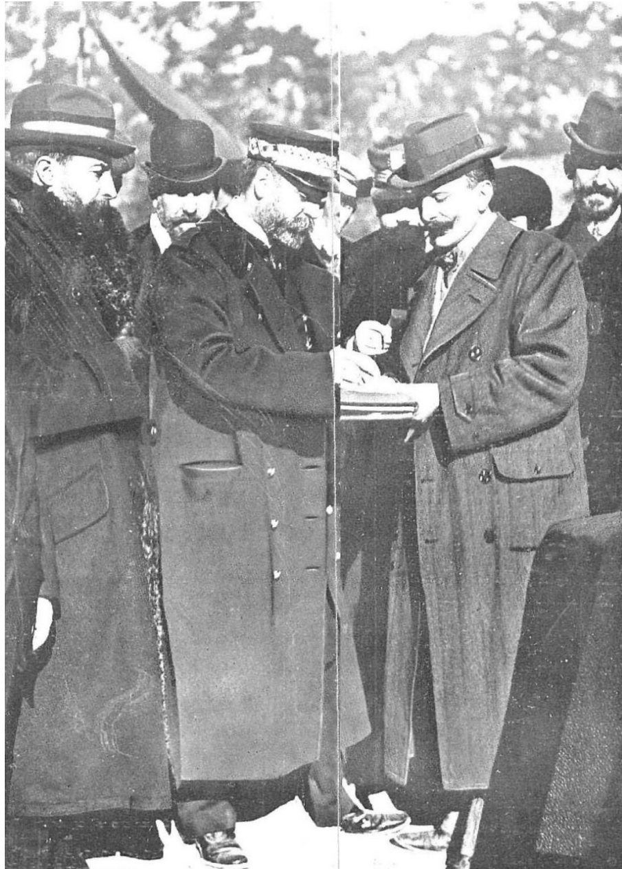
Fig. 71. El ministro de Fomento José Sánchez Guerra durante el acto de inauguración de las obras del túnel del Somport. Imagen extraída de Nuevo Mundo, Madrid, 10 - XII - 1908, n° 779, pp. 16 - 17.
