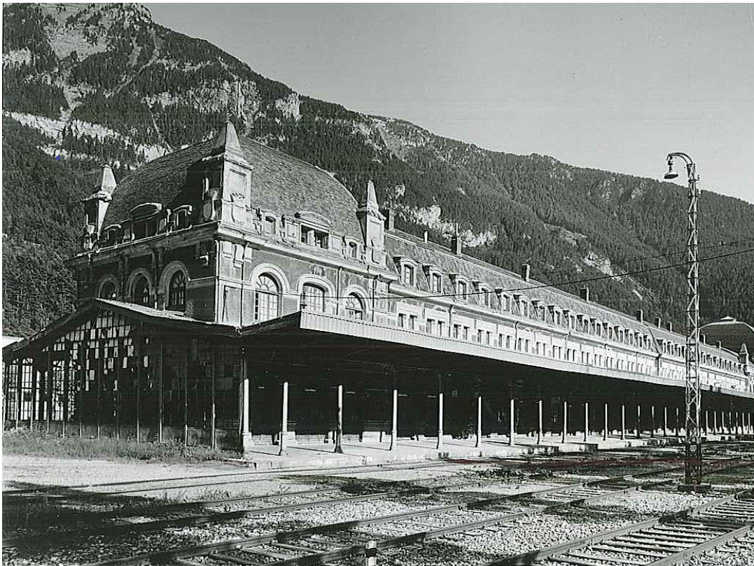
Fig. 181. En la zona de la izquierda de la imagen se puede observar el acristalamiento de cierre en el lado norte del Edificio de Servicio. Foto: Matthias Maas, col. del autor.
