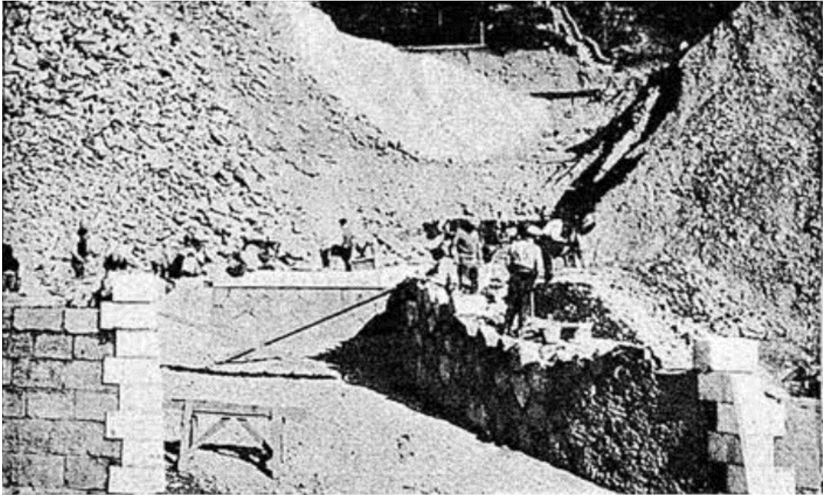
Fig. 98. Encauzamiento del torrente de Epifanio en octubre de 1917. La contrata de la explanada continuó la obra de los ingenieros de Montes, creando las canalizaciones de desagüe excavando en la explanada que, en ese momento, estaba bastante rellena de material aportado. Imagen extraída de la revista Ibérica, Tortosa, Observatorio del Ebro, n° 287 - 88, 19 - 26 - VII - 1919, p. 78.
