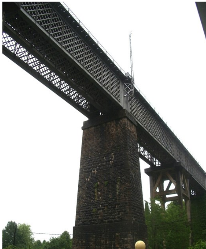
Fig. 17. Viaducto de Ormaiztegui, en la línea Madrid Irún, obra del ingeniero francés Alexander Lavalley en 1864. Fue el primero en el que se empleó este sistema en España. Imagen extraída de https://es.wikipedia.org/wiki/Viaducto_de_Ormaiztegui , Foto Josu Goñi.
