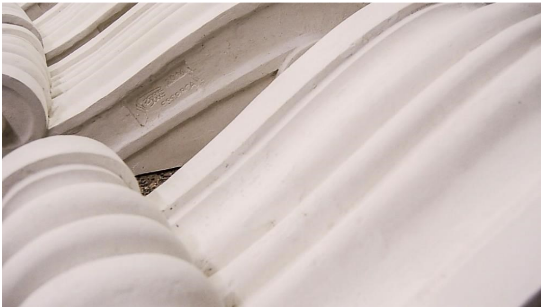
Fig. 316. Detalle del siglado rehundido en el lateral o zonas ocultas en todas las piezas repuestas. Foto del autor.
