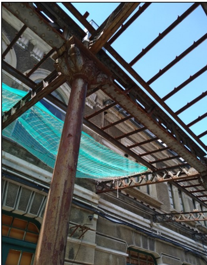
Fig. 18. Estructura metálica en forma de celosía en la marquesina de la estación de Canfranc. Foto del autor.
