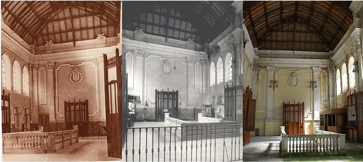
Fig. 250. Tres aspectos del lienzo sur en 1928, c. 1945 y c. 2000. Se observa cómo el vestíbulo se deterioró muy pronto y que los relieves de Mercurio, sobre la cornisa superior, desaparecieron por el peligro que suponían a partir de los años cuarenta del siglo pasado.
