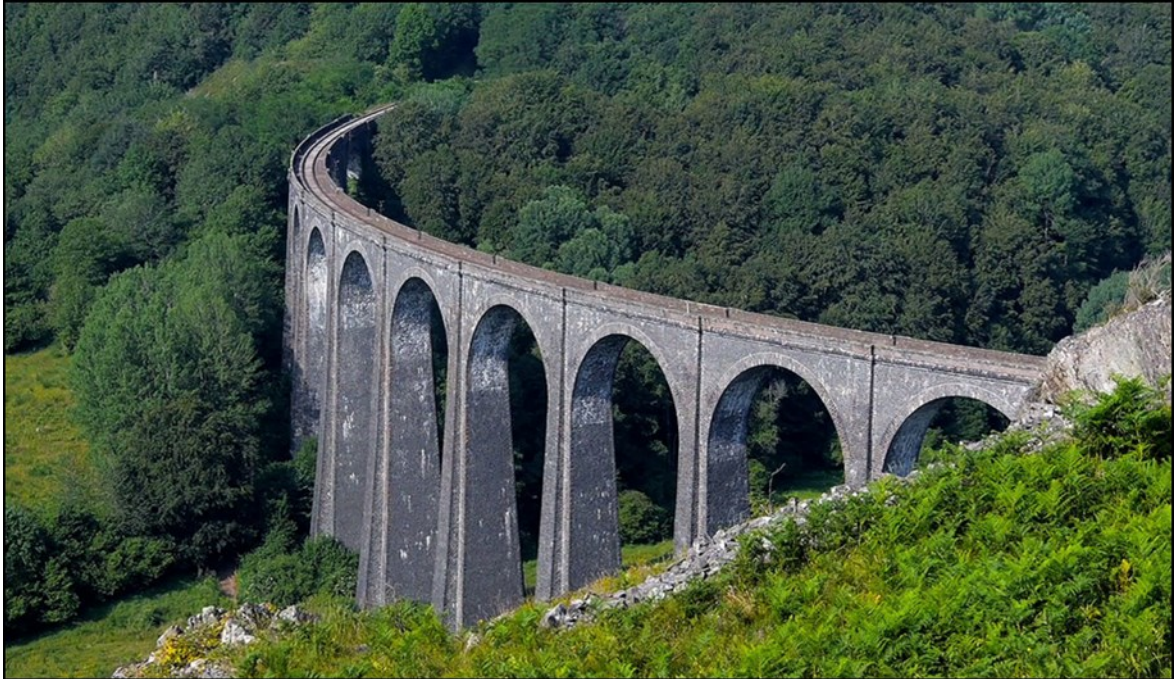
Fig. 33. Viaducto de Barajol, obra del ingeniero Paul Sejourné en la línea Bort-les-Orgues - Neussargues, en Francia, que había sido finalizado en 1908, y precedente del viaducto de Cenarbe. Imagen extraída de https://www.flickr.com/photos/131890483@N06/16775567066
