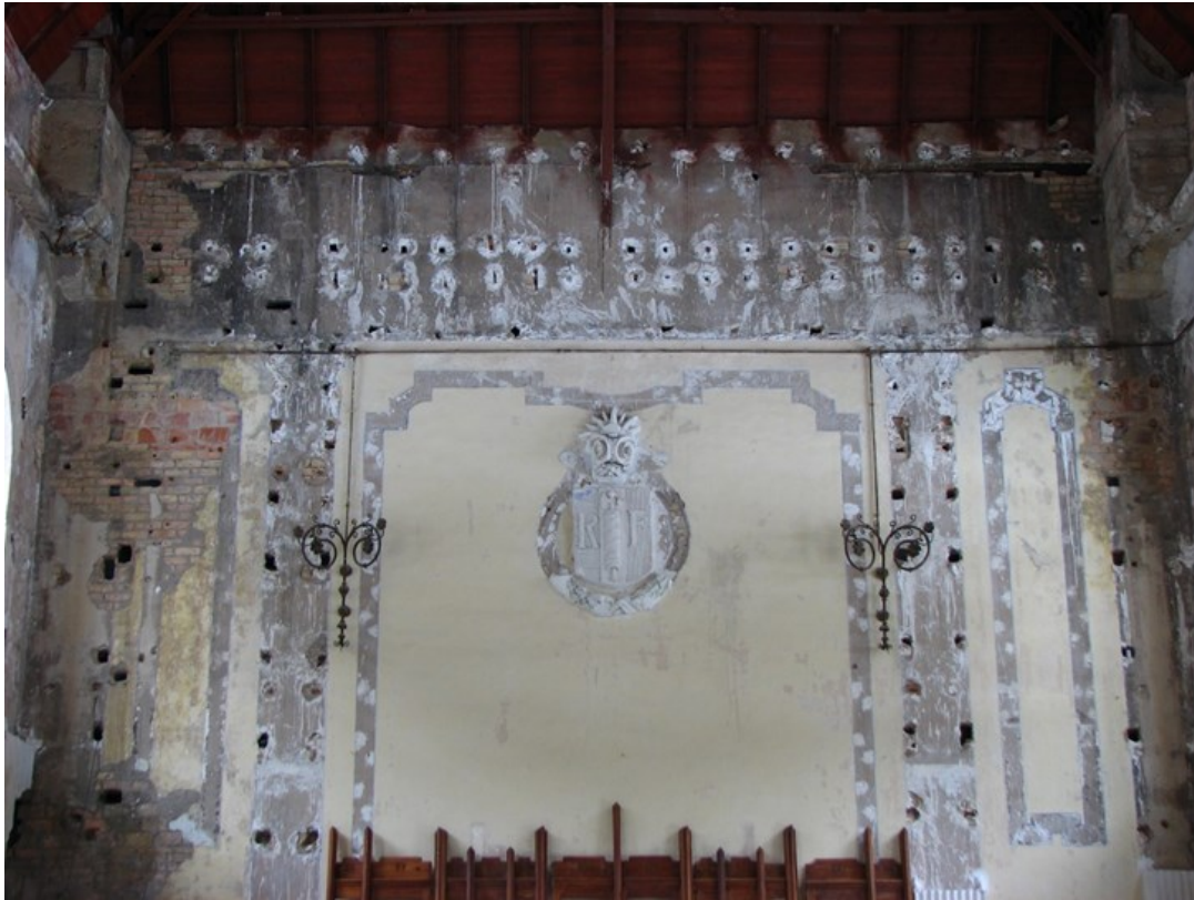
Fig. 311. Situación del lienzo este de del vestíbulo en 2013. Foto: David Ibáñez.
