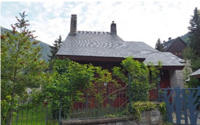
Fig. 295. Casa refugio de Fisac en Canfranc-Estación. Esta casa sirvió de laboratorio para Fisac y en ella ensayó las técnicas constructivas vernáculas. Foto David Ibáñez.
