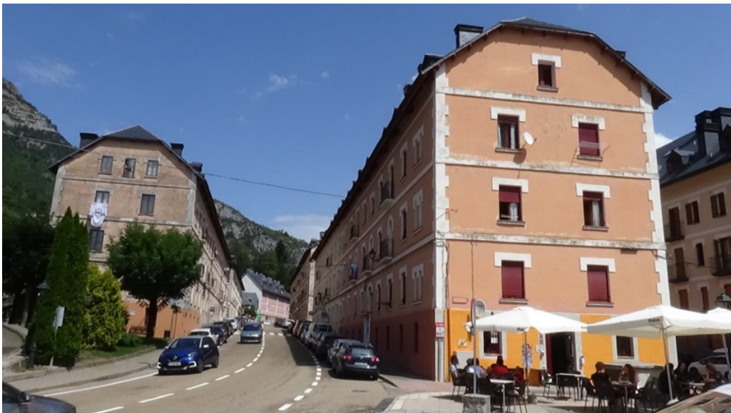
Figs. 269 y 270. Calle principal durante su construcción. La calle era a la vez la carretera Zaragoza- Francia. En primer plano, a la derecha, los edificios 5 y 6 y a la izquierda, los números 17 y 18. A partir de 1931 pasó a denominarse avenida de Pablo Iglesias y, después de la Guerra Civil, del Generalísimo Francisco Franco. Foto: superior Agencia Rol, BNF. Abajo aspecto actual de la calle principal de la localidad, hoy avenida de los Arañones que sigue casi idéntica. Foto inferior del autor.
