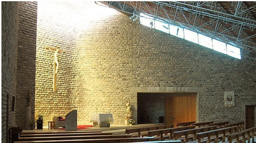
Fig. 299. En el interior de la iglesia no utilizó las «vigas de hueso» para sostener la techumbre, sino que recurrió a estructuras metálicas en celosía. Foto: David Ibáñez.
