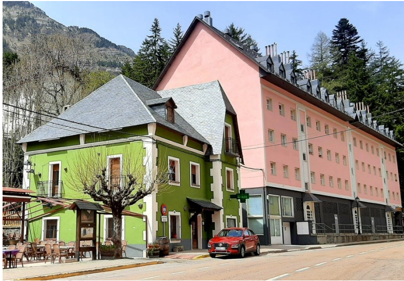
Fig. 277. Aspecto actual del chalet n° 1 que sigue siendo una farmacia. El chalet n° 2, para la vivienda y consultorio médico, fue derribado y en su lugar se construyó el edificio de apartamentos que se vé a la derecha. Foto: David Ibáñez.
