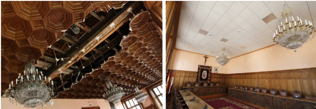
Fig. 199. Salón de plenos del Ayuntamiento de Palencia con decoración original de la empresa Lerchundi, sustituida por placas laminadas tras un desprendimiento en 2018. Imagen extraída de Diario de Burgos https://onx.la/a85b4
