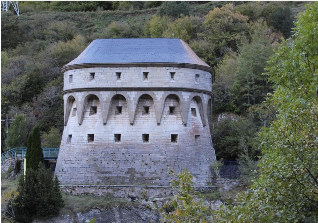
Fig. 61. Torre de Fusileros nº 1. Foto extraída de https://es.wikiloc.com/rutas-senderismo/canfranc-estacion-jaca-camino-santiago-aragones-21366037 .
