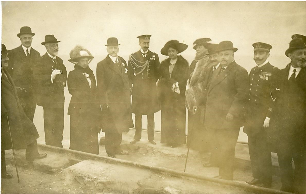
Fig. 76. Visita a las obras del túnel en 1913 con presencia de personal técnico del Ministerio de Fomento e ingenieros militares. Imagen: col. José Gascó Gómez de Membrillera.
