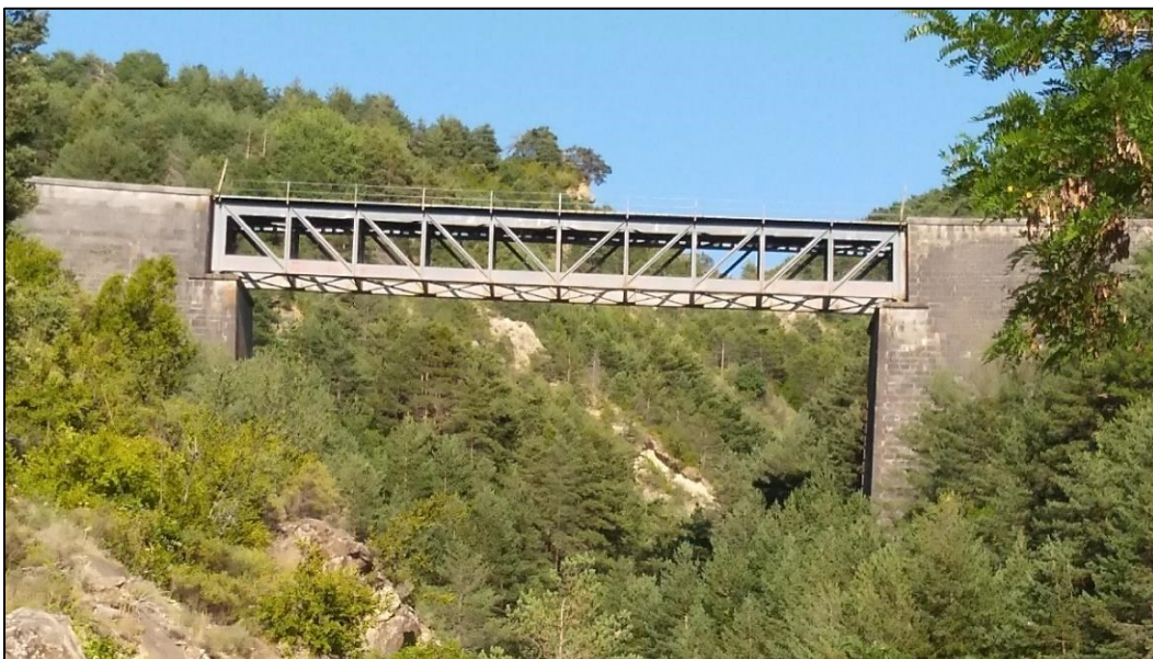
Fig. 38. Viaducto de Villanúa. Modelo de puente viga en celosía, tipo Pratt, Se utilizaba para salvar luces mayores de 10 m. Foto del autor.
