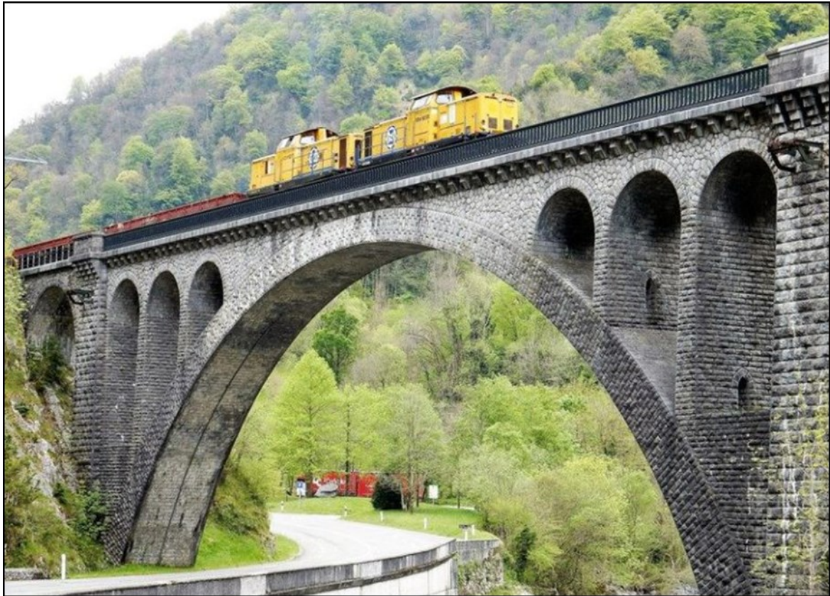
Fig. 36. Viaducto de Escot realizado por los ingenieros franceses Theophile Sentilhes y Debats en 1909. El viaducto está construido en sillaría y mampuesto según los modelos de Sejourne. Foto: Gérard López. Imagen extraída de http://www.crefco.org/201609206152/Vuelve-el-tren-al-Pirineo .
