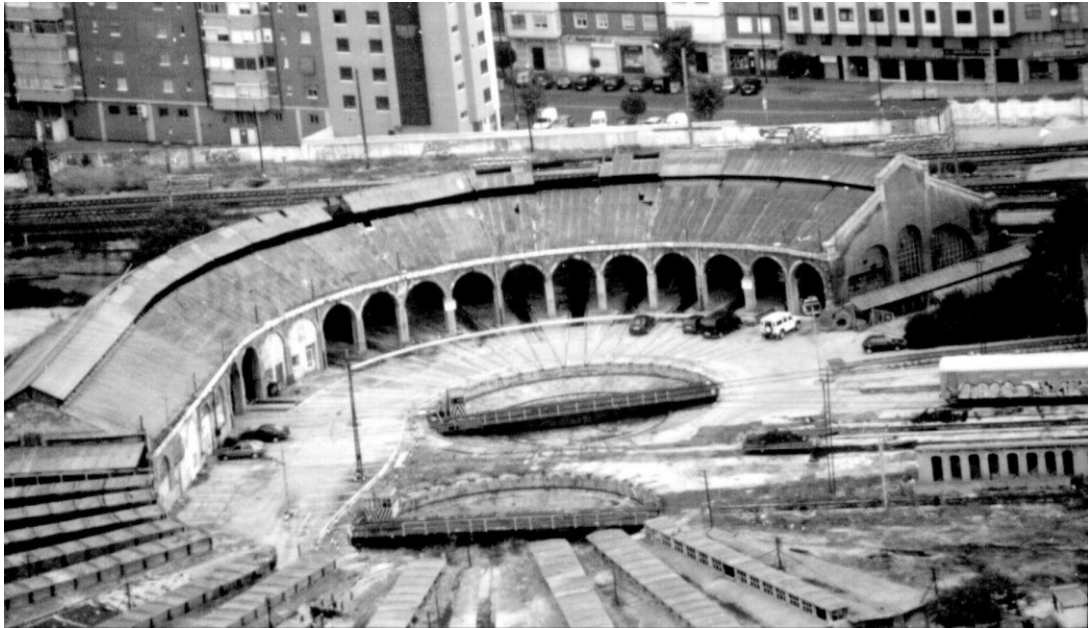
Fig. 150. Antigua rotonda de locomotoras de la estación de Campo Grande en Valladolid con dos semirrotondas unidas por un cuerpo de talleres central y dos puentes giratorios. Hoy en día está en estado de ruina. Imagen extraída de https://vallisoletvm.blogspot.com/2010/03/el-deposito-de-locomotoras-de.html .
