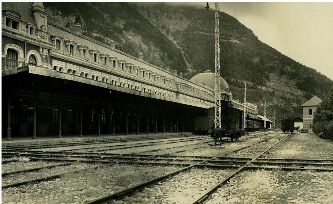
Fig. 155. Carriles transversales del carretón eléctrico en la zona norte de la estación. Foto: FFE. En la imagen se puede observar cómo eran los carriles del carretón, que estaban segmentados para no interrumpir el recorrido de los raíles longitudinales de la línea.
