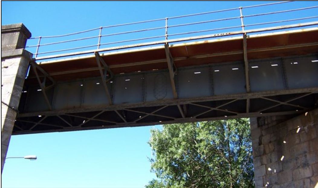
Fig. 37. Viaducto de Castiello de Jaca. Se trata de un modelo sencillo con dos vigas de hierro unidas mediante remaches apoyadas sobre estribos de fábrica. Eran los más adecuados para salvar pequeñas luces. Foto del autor.
