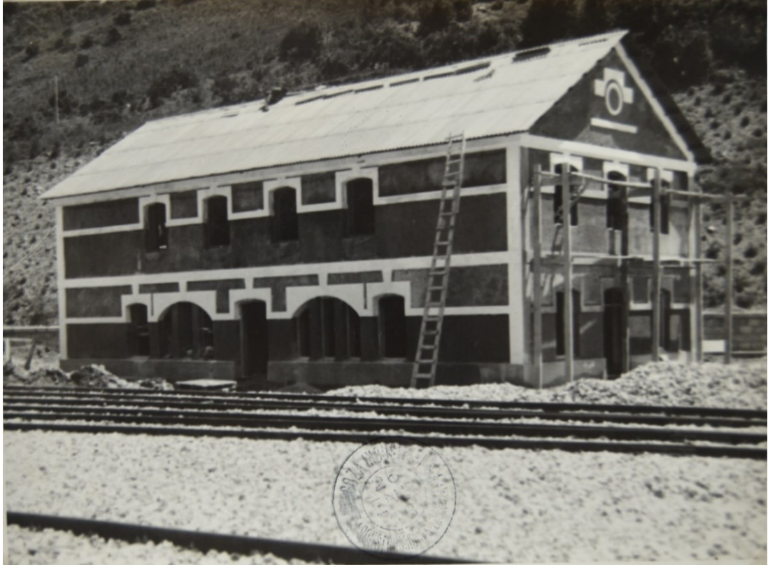
Fig. 164. Dormitorio de maquinistas españoles en fase de construcción. Foto: Colección Alonso Robisco. En estos edificios también participó la empresa Zaragoza Industrial S.A.
