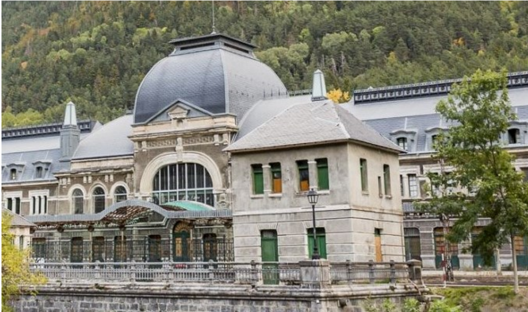
Fig.173. En primer plano el Pabellón de policía en el patio de viajeros en su estado actual. Imagen extraída de https://www.turismodearagon.com/ficha/estacion-internacional-de-canfranc/ .
