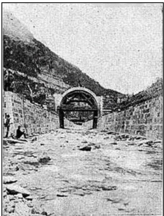
Fig. 101. Tres momentos en la construcción del puente de acceso a la explanada de la estación. Imagen extraída de la revista Ibérica, n° 287 - 288, 19 - 26 - VII - 2019, p. 73.
