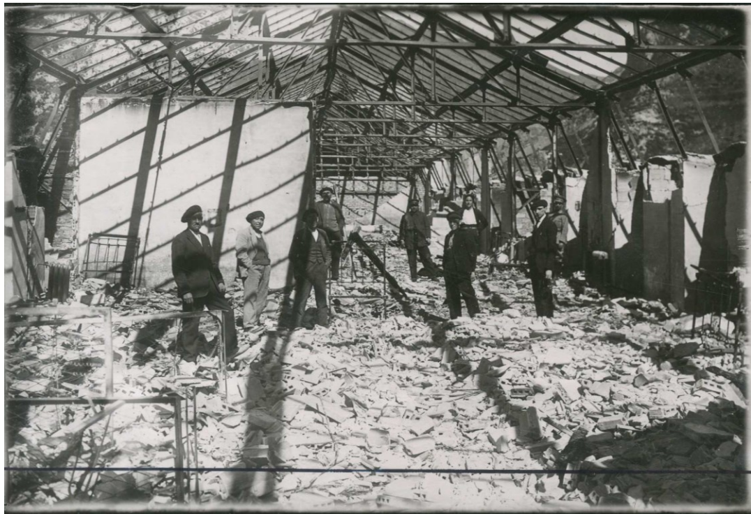
Fig. 242. Fotografía de los daños del incendio en la segunda planta de la zona sur que se conserva en el AGA, Caja 33/01204.
