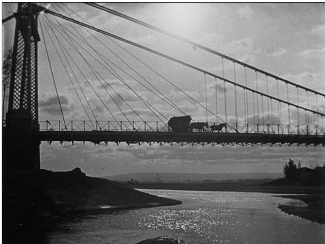
Fig.14. Antiguo puente de Santa Isabel sobre el río Gállego en Zaragoza, obra del ingeniero Louis de la Martiniere en 1841. Foto Gran Archivo Zaragoza Antigua (GAZA).
