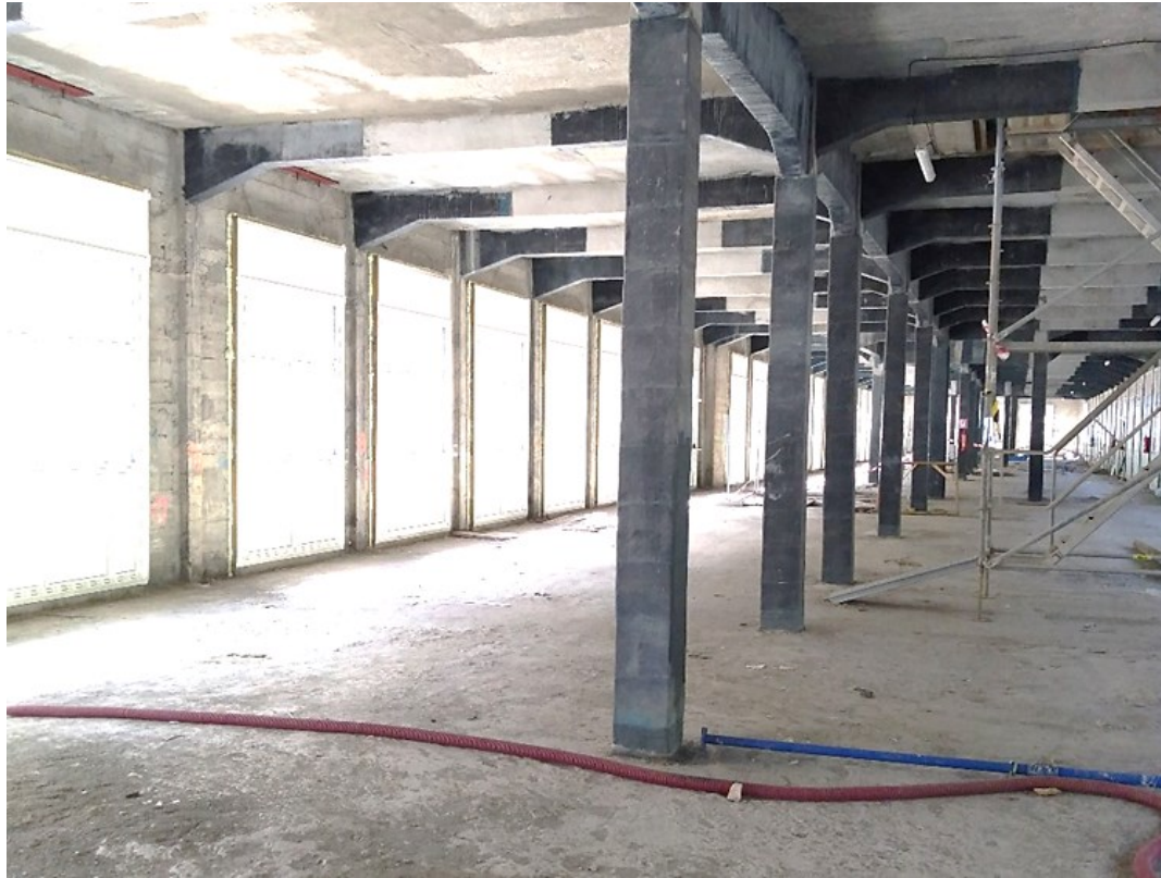
Fig. 315. Interior del ala sur una vez eliminada toda su distribución. En ese espacio se ubicaba el salón comedor del Hotel Internacional que se recoge en la fig. 308. Foto del autor.
