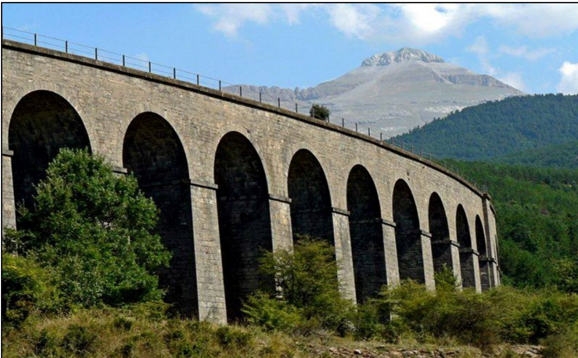
Fig. 34. Viaducto de Cenarbe obra del ingeniero Javier Sanz Larumbe, finalizado el 24 de junio de 1916. El viaducto no es tan airoso como los diseñados por Sejourné. Imagen extraída de http://www.crefco.org/Articulo007.htm .
