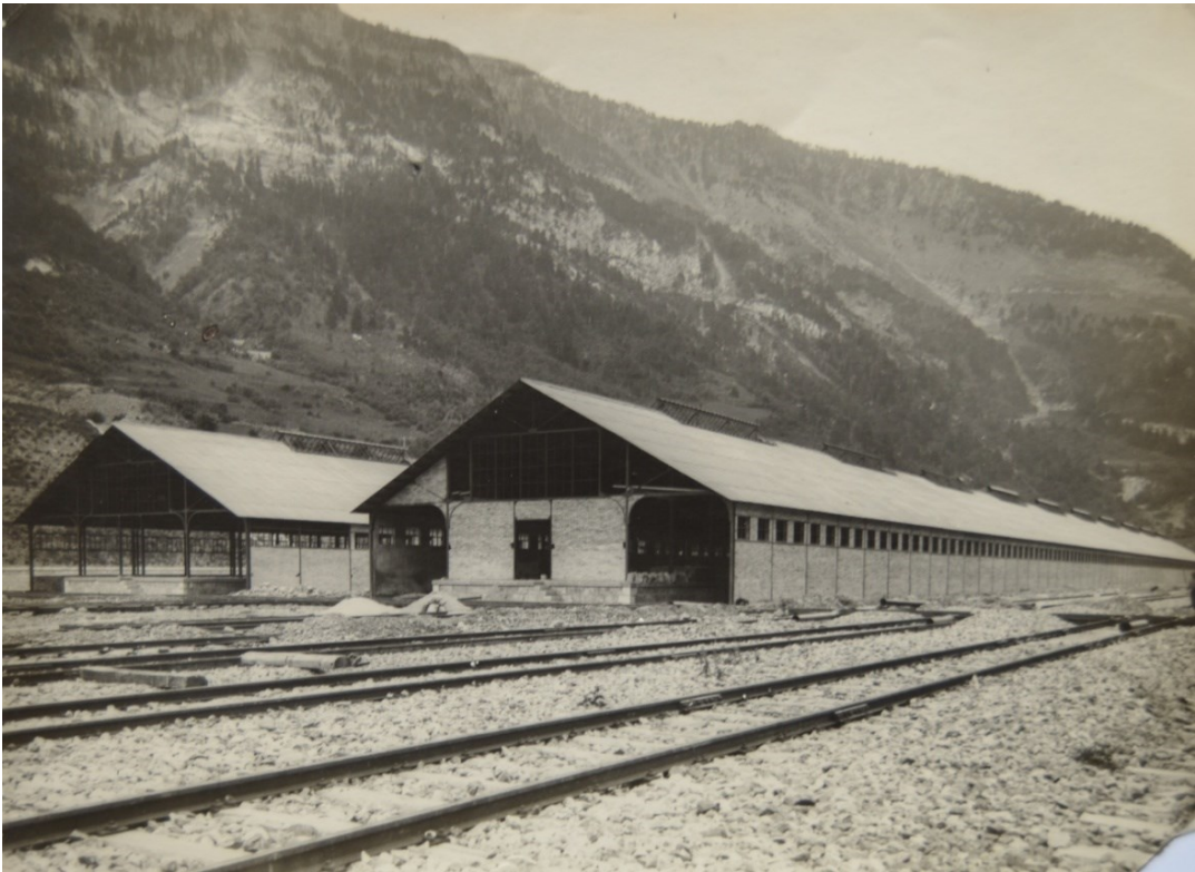
Fig. 144. Muelles de baja velocidad casi acabados, vistos desde la zona norte. Fotógrafo desconocido, hacia el verano de 1926. Colección Alonso Robisco,
