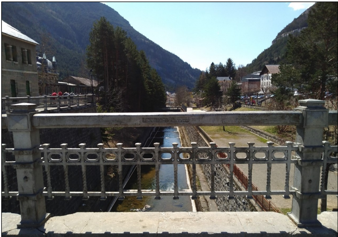
Fig. 102. Módulo de barandilla de hierro fundido realizado por la fundición Luzuriaga de Pasajes Guipúzcoa, para la Estación de Canfranc. Foto del autor
