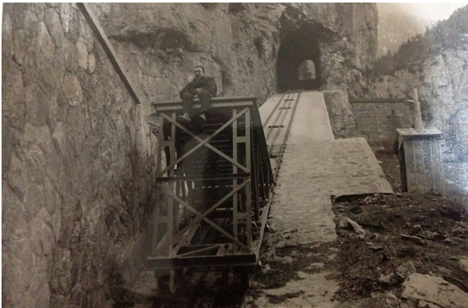
Fig. 302. Imagen del plano inclinado que salvaba el desnivel entre el embalse de Ip y la central inferior y que sirvió para transporte de materiales y personal durante las obras. Foto: col. Víctor López Morales.
