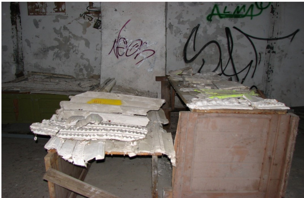
Fig. 3. Restos de la decoración en escayola del Edificio de Servicio localizados en el pabellón de paquetes postales en 2013. Foto del autor.
