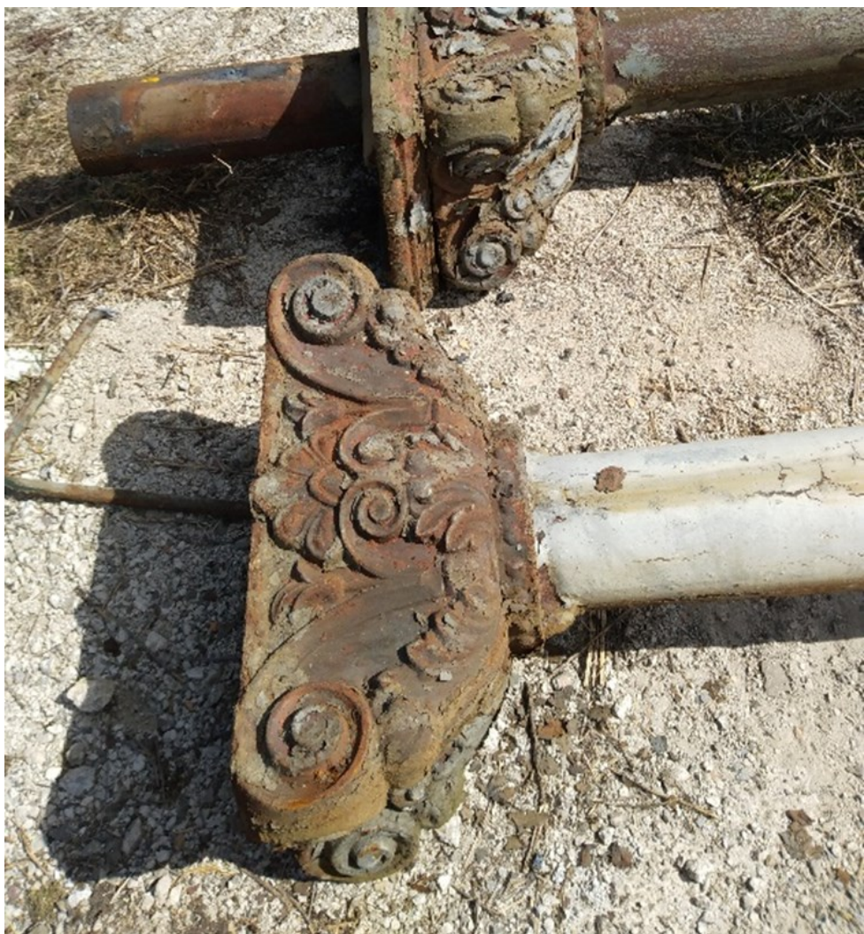
Fig. 15. Capiteles de hierro fundido de la marquesina de Canfranc. Desmontados en la intervención de 2019. Foto del autor.
