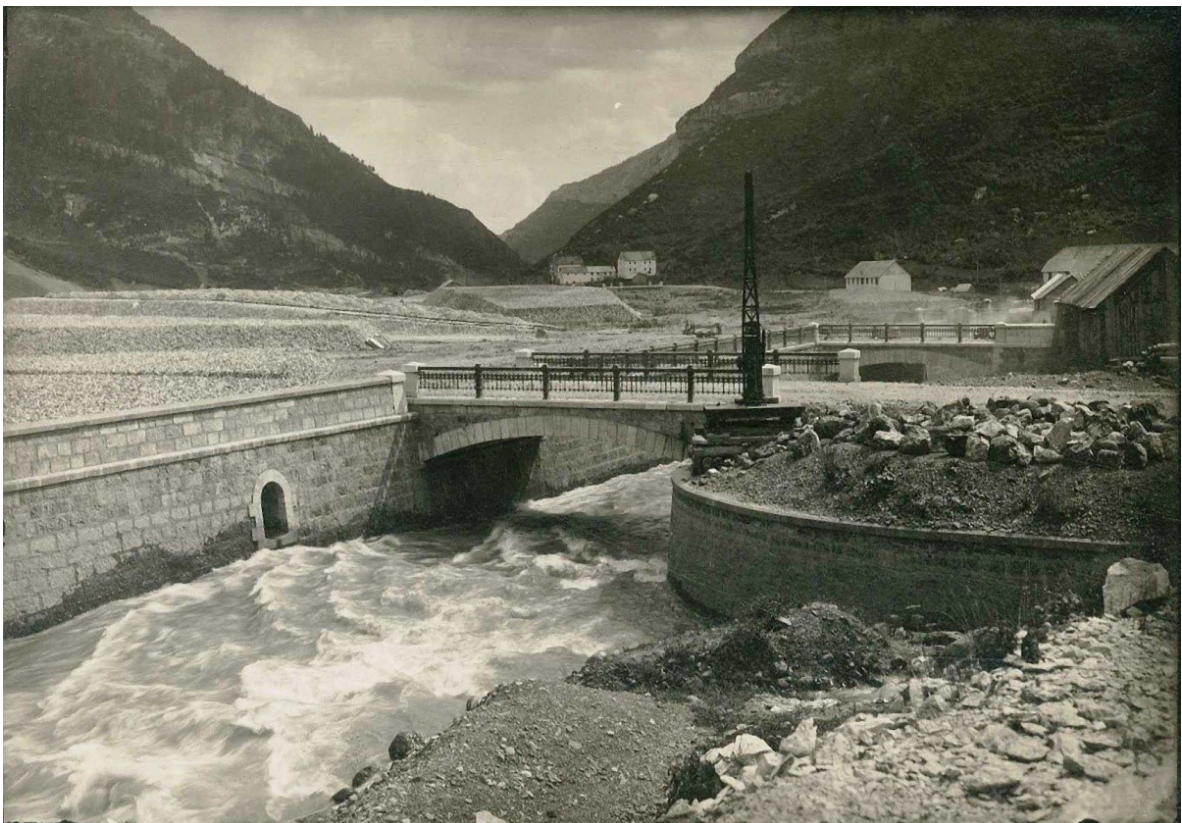
Fig. 104. Puentes 2 y 3 en la parte norte de la explanada para acceder al túnel y a la carretera respectivamente. Foto: AGA, Caja 33/01204.
