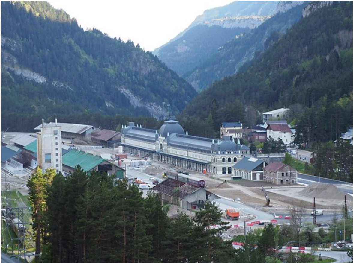
Fig. 326. Aspecto de la estación, en obras de rehabilitación para su reapertura, en fecha de cierre de la tesis doctoral en mayo de 2022. Foto David Ibáñez.
