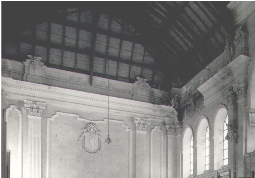
Fig. 206. Punto de luz suspendido de la techumbre en uno de los lados cortos del vestíbulo. En los lados largos ya se habían colocado las lámparas, imagen de los años cuarenta, siglo XX. Foto: FFE.
