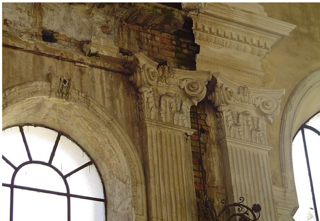
Fig. 202. Capiteles, cornisas y pilastras del vestíbulo de Canfranc. Todos estos elementos de gran tamaño estaban fabricados con moldes flexibles y colocados después en obra mediante el sistema de encarcelado. Foto: David Ibáñez.
