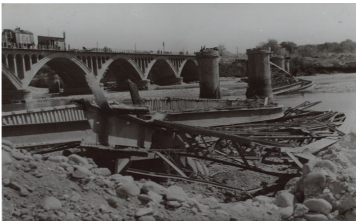
Fig. 4. Puente del ferrocarril sobre el río Cinca en Monzón (Huesca), volado durante la Guerra Civil. Foto Diego Quiroda Losada, BNE. Sorprendentemente el puente de la carretera no fue destruido.
