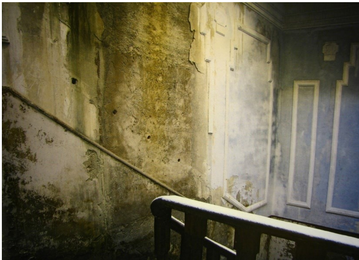
Fig. 249. Subida de la escalera del hotel con aplicaciones decorativas en escayola donde se vislumbra el estilo Art déco. Foto: Andrés Ferrer.
