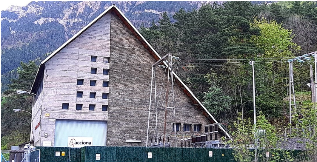
Fig. 307. Edificio construido en 1967 de la central de Canalrroya. Fisac yuxtapone en la fachada sur su material predilecto, el hormigón, en este caso visible, con el sillarejo, típico de las construcciones locales. Foto: David Ibáñez.
