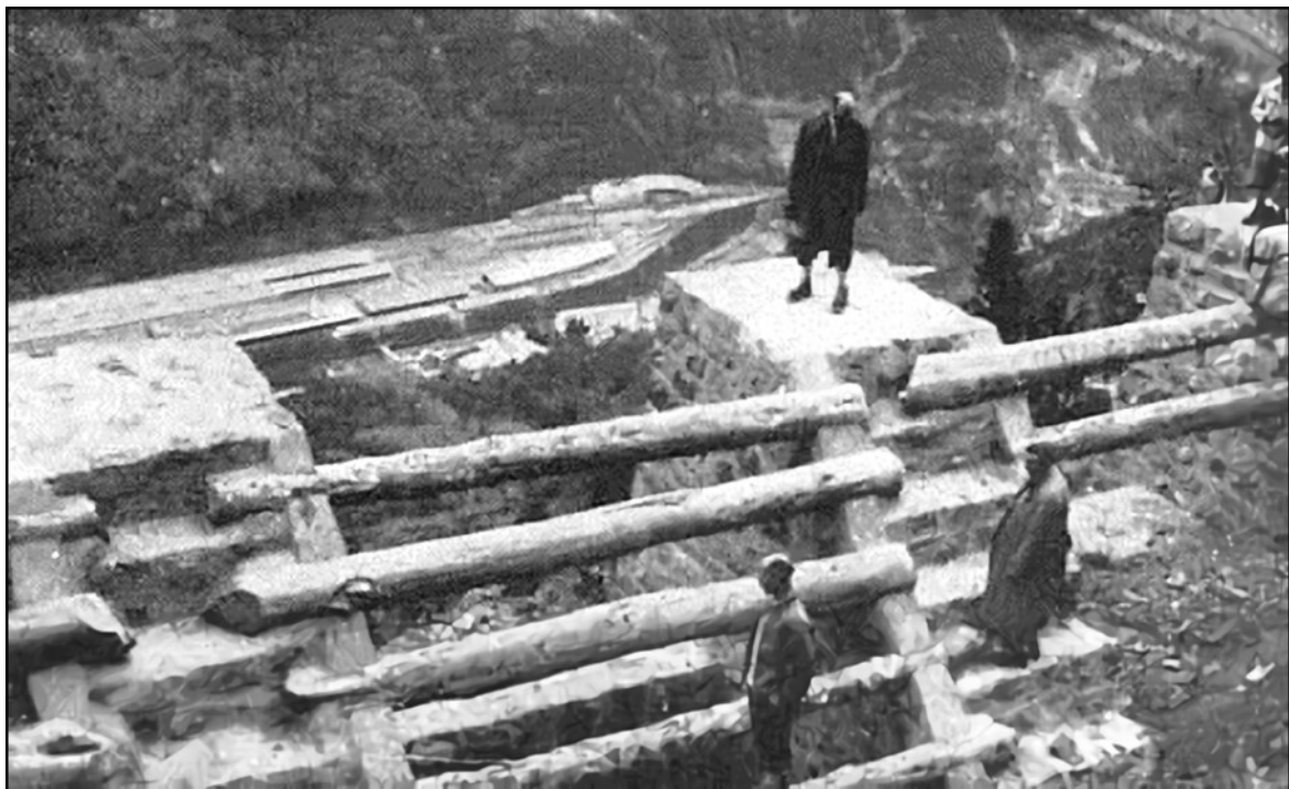
Fig. 91. Puente de nieve o rastrillo realizado con troncos, construido a principios de los años 50, del siglo XX, en el torrente de Estiviellas. En mayo de 1955, varios ingenieros forestales de las secciones Alpes y Pirineos, de la Dirección de Aguas y Montes (Francia), efectuaron una visita a los trabajos de defensa contra aludes y corrección de torrentes efectuados en el Pirineo español. Fueron guiados por sus colegas españoles de la 6ª Región Hidrológico-Forestal del Patrimonio Forestal del Estado. Un funcionario de la Dirección de Montes de la Food and Agricultural Organization (FAO), cuyo nombre desconocemos, fue invitado a agregarse al grupo y fruto de ese viaje apareció en la revista Unasyuva editada por la mencionada FAO, un extraordinario artículo del que hemos extraído la imagen, véase Unasyuva, v. 9, nº 3, 1955.
