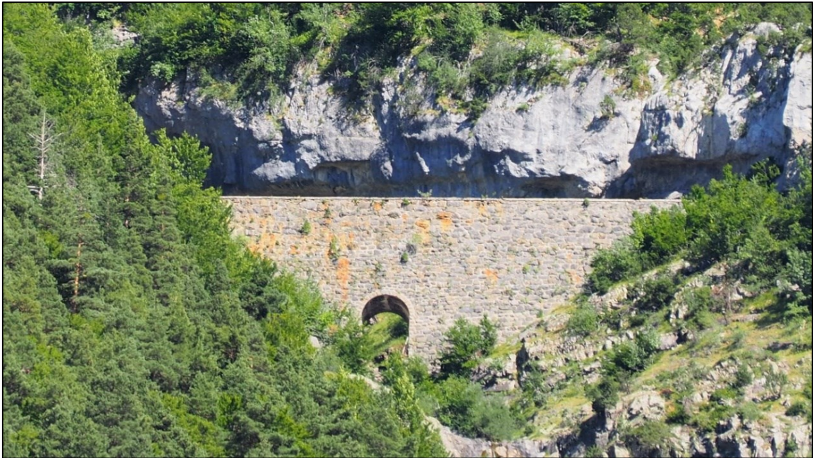
Fig. 92. «Dique vacío» en el torrente de Epifanio, con su gran mechina central de 4 m de luz y 10 m de altura. Foto: David Ibáñez.
