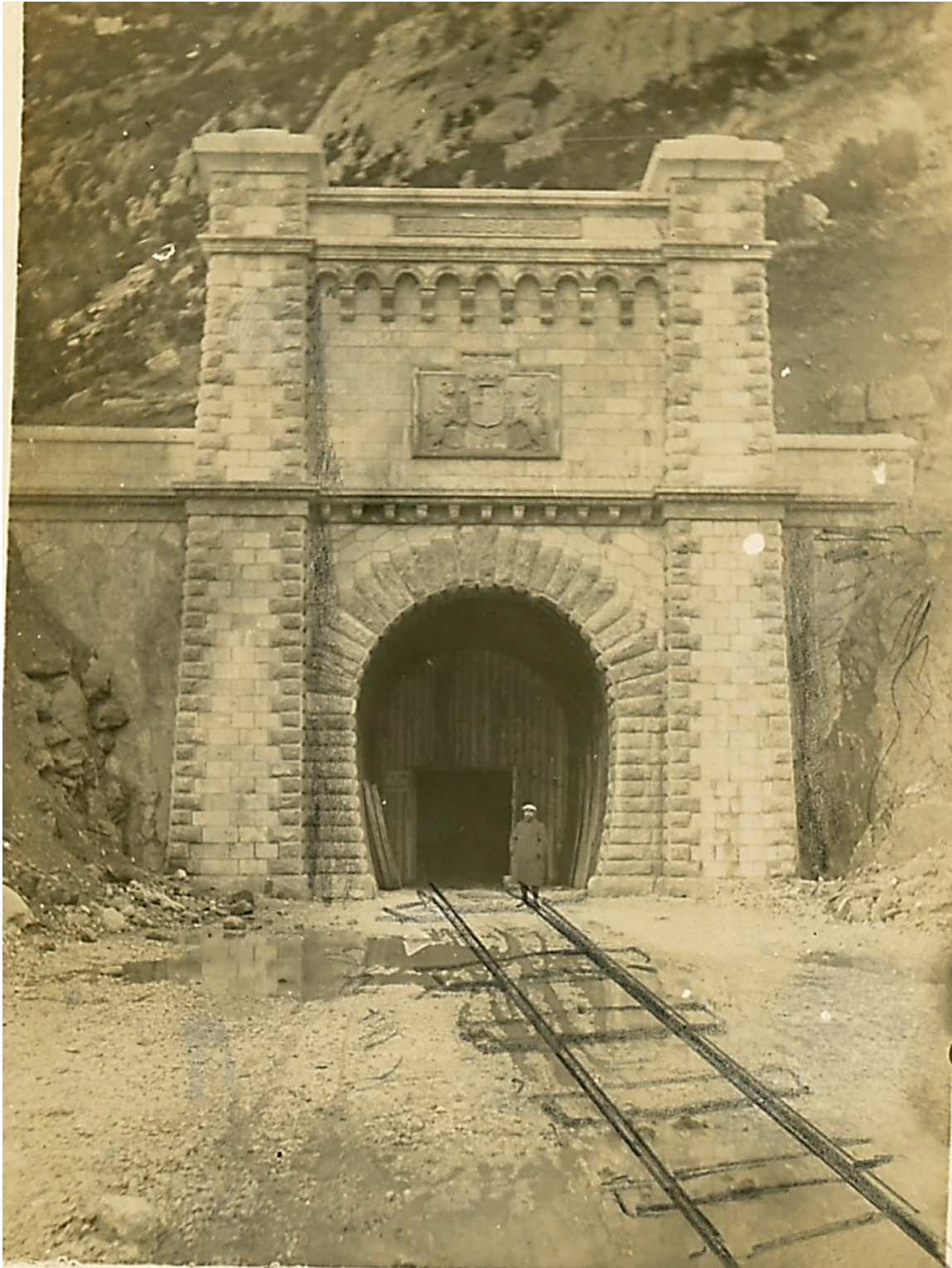
Fig. 77. Imagen de la embocadura del túnel con la puerta que se dispuso en 1914 para tratar de evitar el contrabando. En la fotografía se dibujaron las vías que se iban a colocar. Foto: col. José Gascó Gómez de Membrillera.
