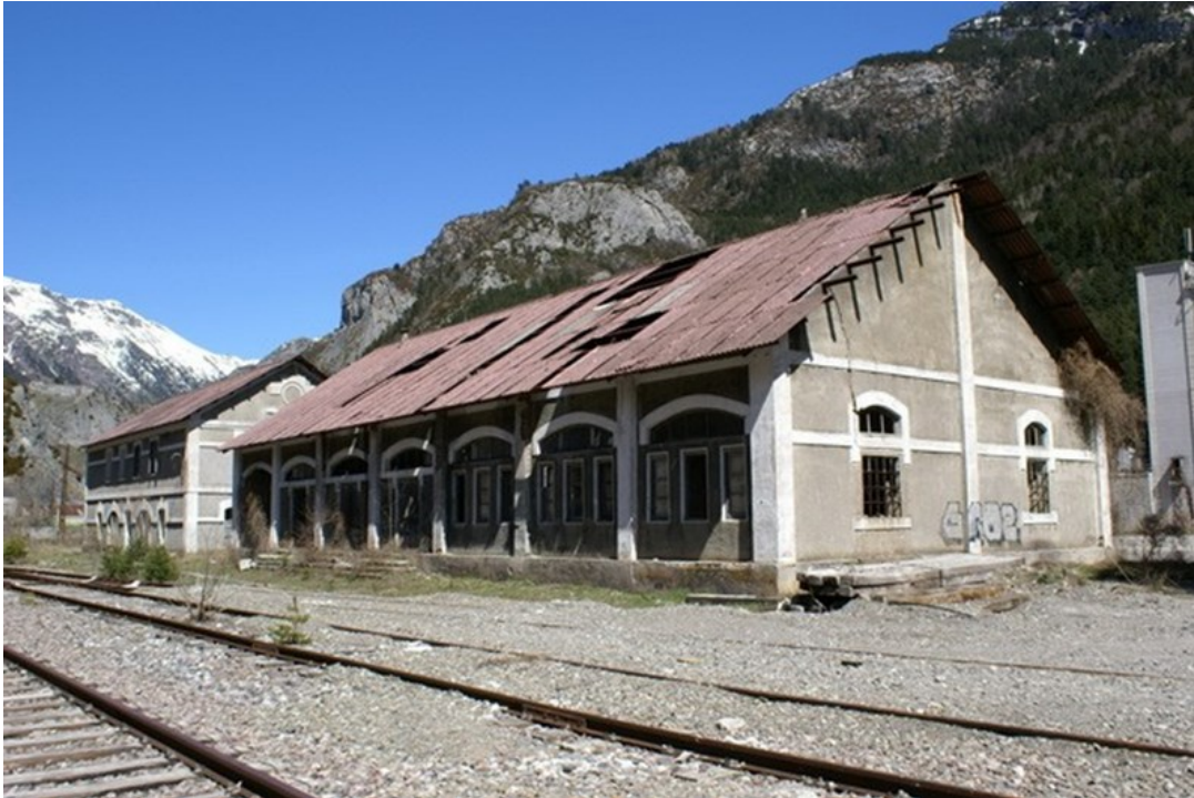
Fig. 170. Pabellón sanitario entre el dormitorio de agentes franceses y el Edificio de Servicio en 2008. http://esperandoaltren.blogspot.com/2013/03/el-canfranc-2-parte.html .
