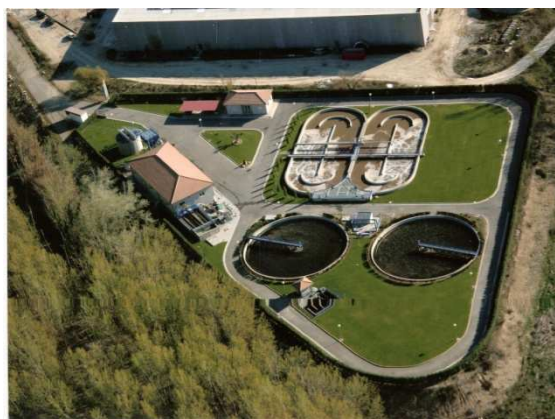
Figura 1 Vista general EDAR Barbastro
