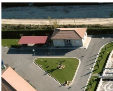
Figura 3 Edificio de control
