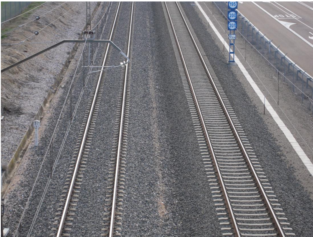
FIGURA 12. EJEMPLO DE VÍA DOBLE ELECTRIFICADA
