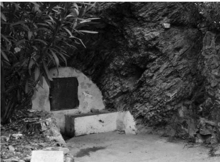
Figura 1. Estado actual de la boca de entrada de la galería de desagüe, inacabada, de la mina Colosal Platífera, en Alpartir.
