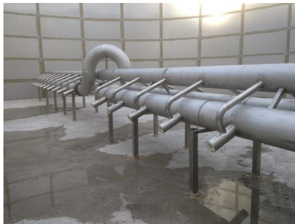
Figura 17. Sistema de aireación AEMJET-I. (Aguas industriales)
