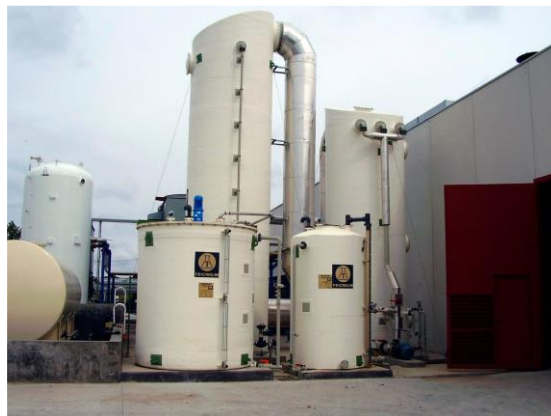
Figura 22. Columna de Stripping . (Fuente: Tecnum)
