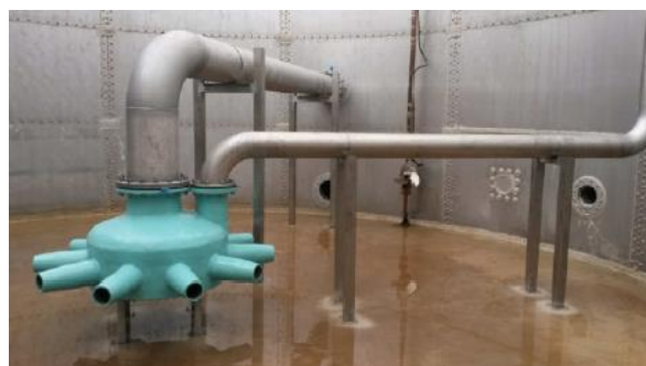
Figura 21. Sistema de aireación/agitación AEMJET-O. (Fuente: AEMA)
