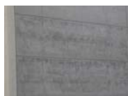
Ilustración 31: Muro de medianera
