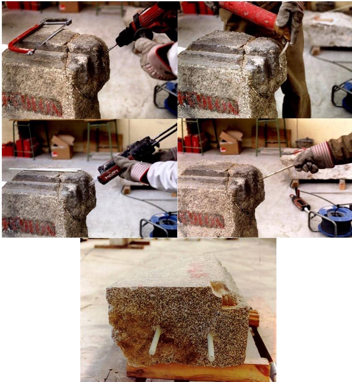
Figura 2. Proceso de cosido con varillas de vidrio (42)
