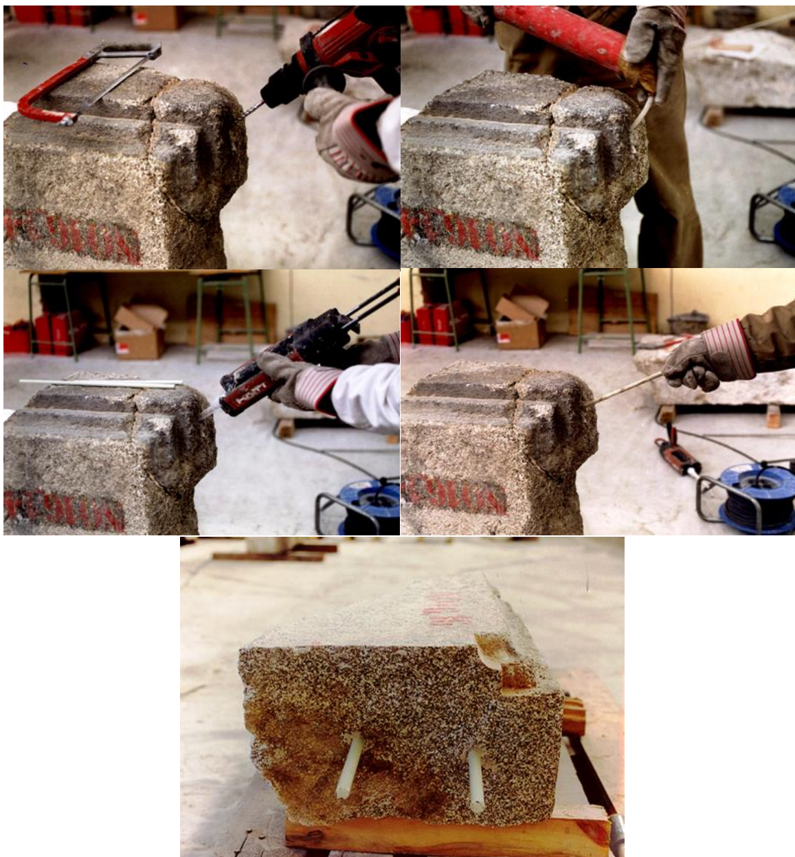
Figura 65. Proceso de cosido con varillas de vidrio (43)
