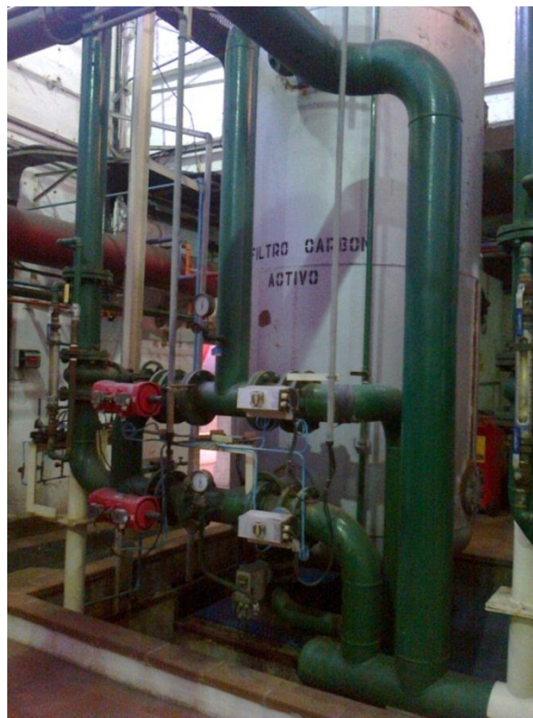
Figura 23: Filtro de carbón activo a presión
