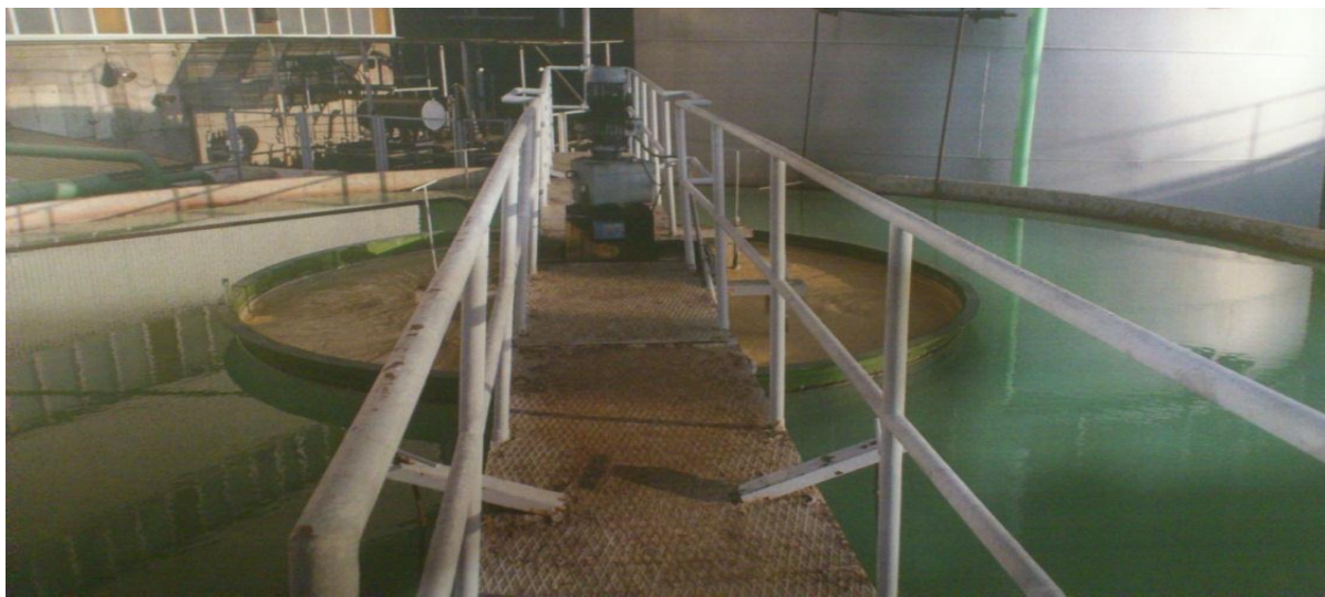
Figura 19: Decantador ACCELATOR
