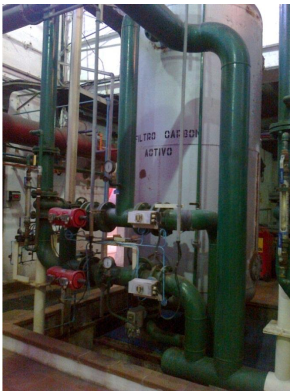
Figura 8: Filtro de carbón activo a presión
