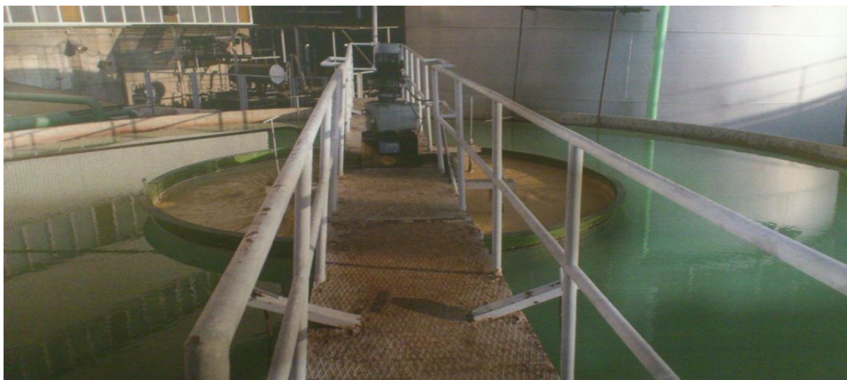
Figura 4: Decantador ACCELATOR
