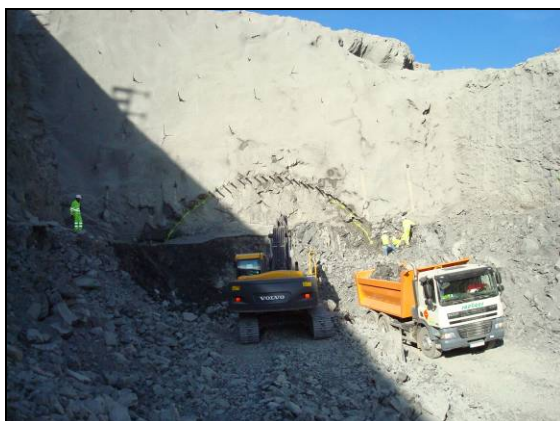
Fig. 1.10. Ejecución de emboquille sur y transporte y carga de material. Cortesía F.C.C.
