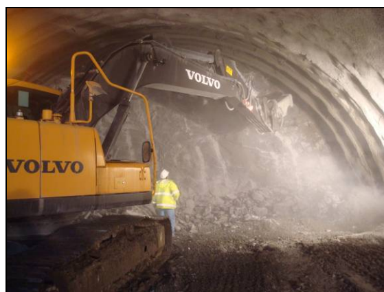
Fig. 1.9. Ejecución de la perforación de barrenos para voladura y saneo. Cortesía F.C.C.
