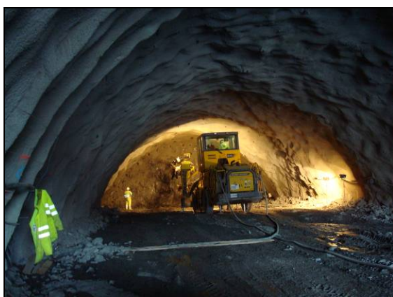
Fig. 1.9. Ejecución de la perforación de barrenos para voladura y saneo. Cortesía F.C.C.
