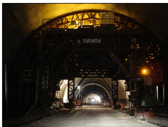
Fig. 1.12. Plataforma para instalación de la impermeabilización y carro encofrador del revestimiento. Cortesía F.C.C.
