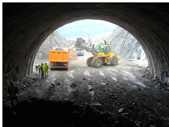
Fig. 1.10. Ejecución de emboquille sur y transporte y carga de material. Cortesía F.C.C.
