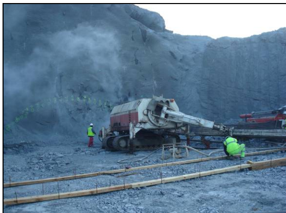
Fig. 1.11. Ejecución de paraguas de micropilotes y colocación de cercha en emboquille sur. Cortesía F.C.C.
