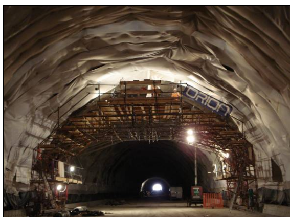
Fig. 1.12. Plataforma para instalación de la impermeabilización y carro encofrador del revestimiento. Cortesía F.C.C.
