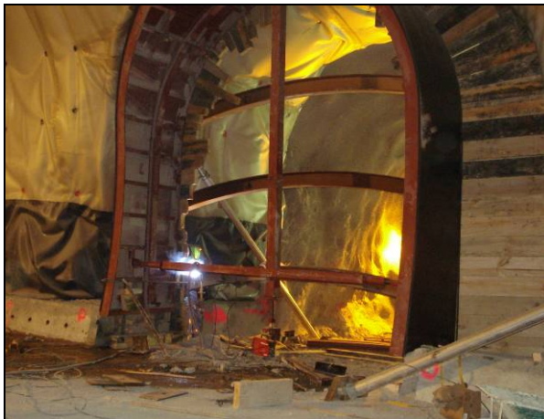
Fig. 1.5. Detalle de ejecución del entronque del túnel con la galería peatonal. Cortesía de F. C. C.
