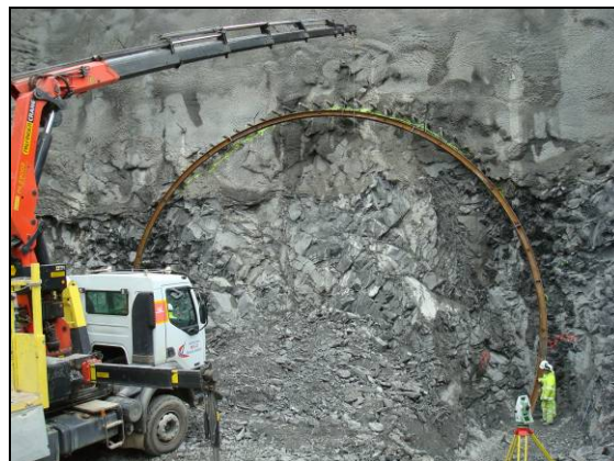
Fig. 1.11. Ejecución de paraguas de micropilotes y colocación de cercha en emboquille sur. Cortesía F.C.C.
