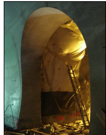
Fig. 1.5. Detalle de ejecución del entronque del túnel con la galería peatonal. Cortesía de F. C. C.
