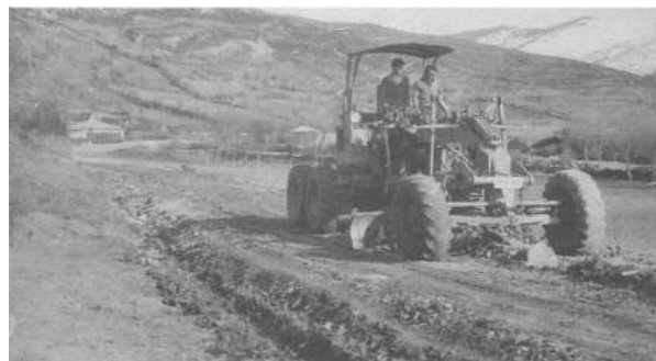
Fig. 46. Máquina montielevadora abriendo la pista forestal junto a Bescós de La Garcipollera. Foto: Archivo Cartagra
