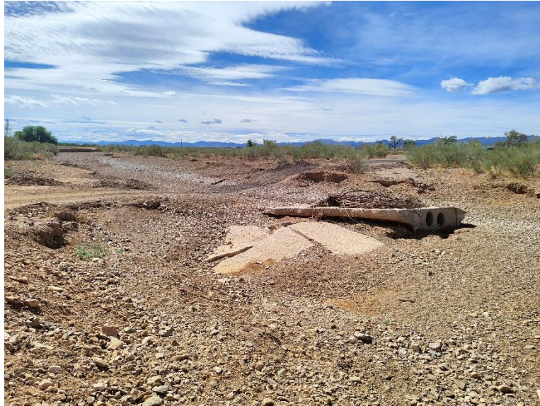
Figura 29. Rotura del vado de la rambla de Cariñena provocado por una tormenta del año 2022. [ Fuente: propia. Fecha de elaboración: 9 de septiembre de 2022 ]
