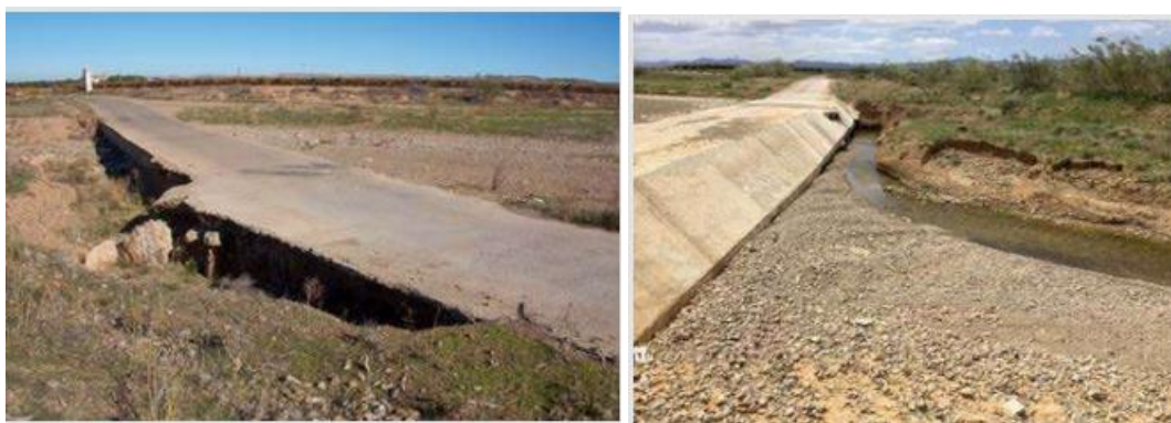
Figuras 26 y 27. El mismo vado que la imagen 25, sufrió una importante socavación aguas abajo (figura 26 izquierda) durante la avenida de marzo de 2015 y fue reforzado, como se observa en la figura 26 (derecha). [Fuente: Ollero et al., coord. 2021]
