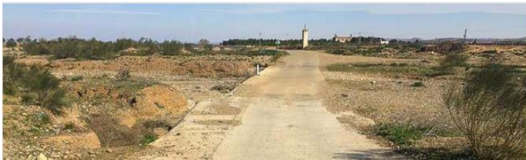
Figura 25. Vado en la rambla de Cariñena muestra claramente la retención de material aluvial arriba (derecha) y un escarpe erosivo al pie del obstáculo (izquierda) con efecto presa. [Fuente: Ollero et al., coord. 2021]
