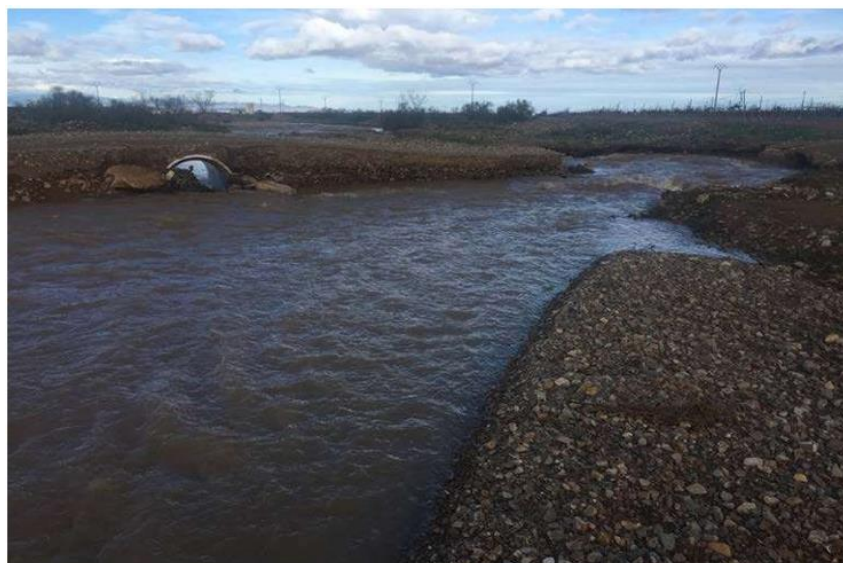
Figura 44. La crecida en la rambla de Cariñena a raíz del episodio Gloria (enero 2020) destruye el vado de la Virgen de Lagunas, resultando inútil el único tubo existente bajo el mismo. Al parecer, este vado es ilegal y son los propietarios locales los que lo rehabilitan por su cuenta tras cada avenida. [Fuente: Ollero et al., coord. 2021]
