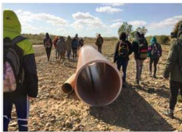
Figura 28. Tubo del vado de la Virgen de Lagunas en la rambla de Cariñena arrancado por la avenida de marzo de 2018. [Fuente: Ollero et al., coord. 2021]
