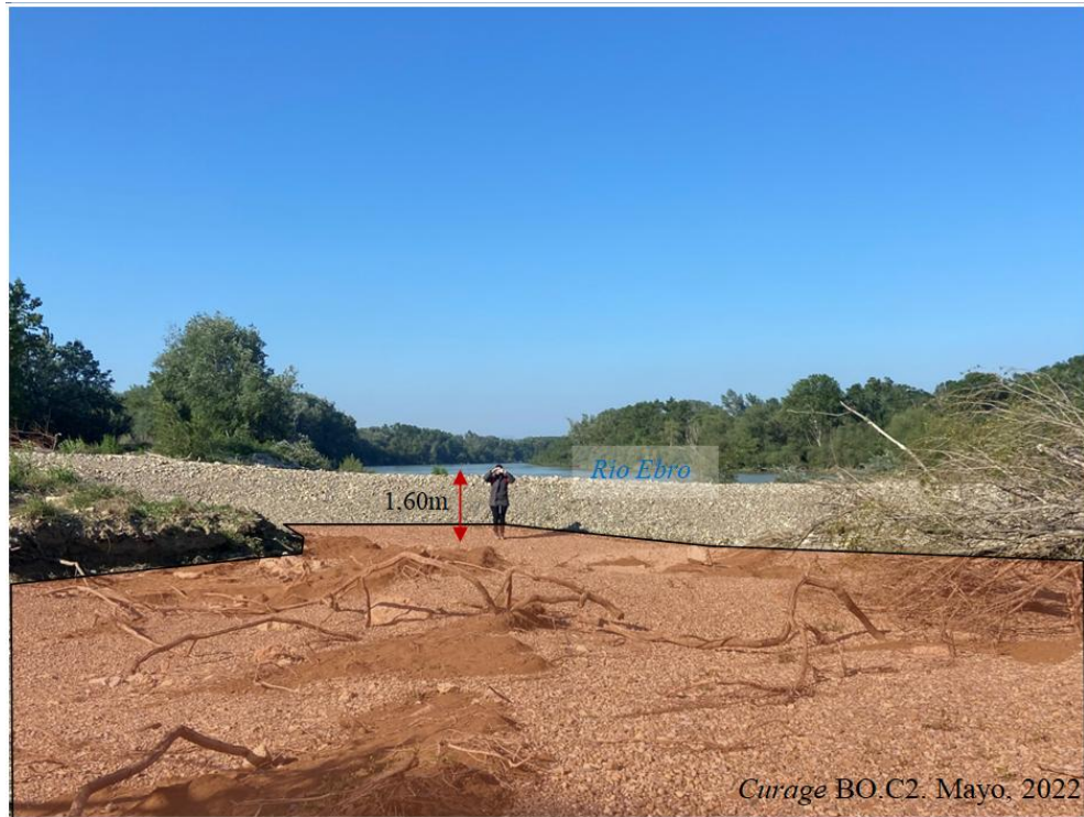
Figura 41. Acumulación de sedimentos en el curage BO. C2.
