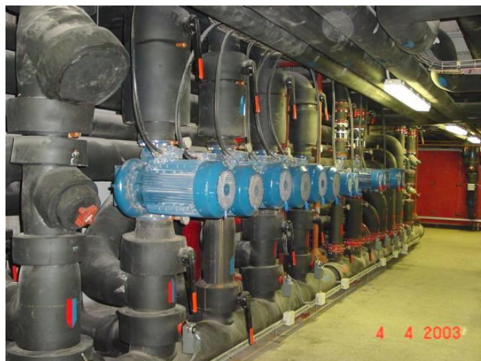
Figura 32. Bombas hidráulicas del secundario de la instalación. Fuente: Carlos Monné.
