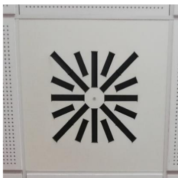
Figura 34. Difusor rotacional de los despachos de los departamentos (DIM). Fuente: Carlos Monné.
