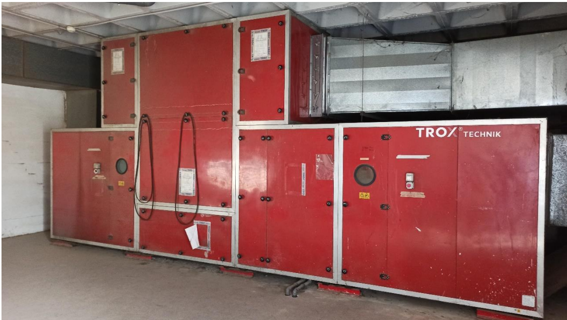
Figura 29. Fotografía de la climatizadora de las aulas (CL-1). Fuente: Autor.
