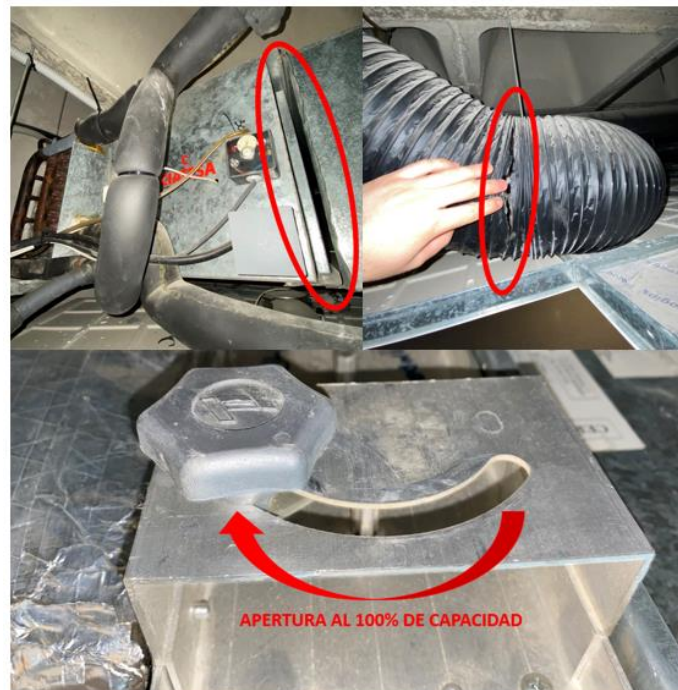
Figura 75. Incidencias descubiertas durante las mediciones: huecos en equipos de climatización (arriba, izquierda), roturas en conductos (arriba, derecha) y compuertas cerradas (abajo). Fuente: Autor, Miguel García-Monge y Michael Marchica.
