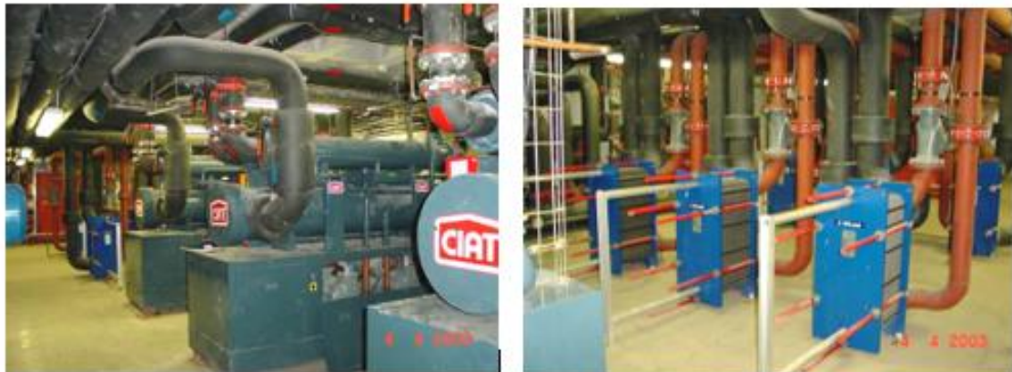
Figura 31. Bombas de calor (izquierda) e intercambiadores de placas (derecha) de la instalación. Fuente: Carlos Monné.
