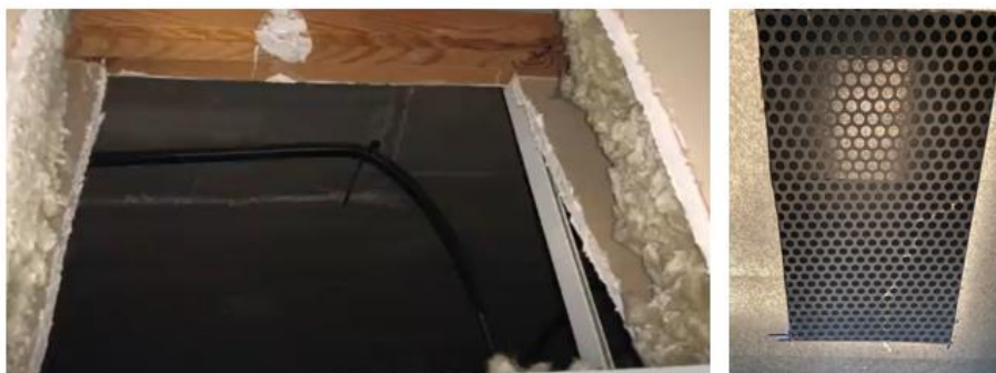
Figura 76. Huevo de ventilación entre clases y pasillo del falso techo (izquierda) y rejilla de retorno en los conductos de ventilación de los pasillos (derecha). Fuente: Elab. propia.
