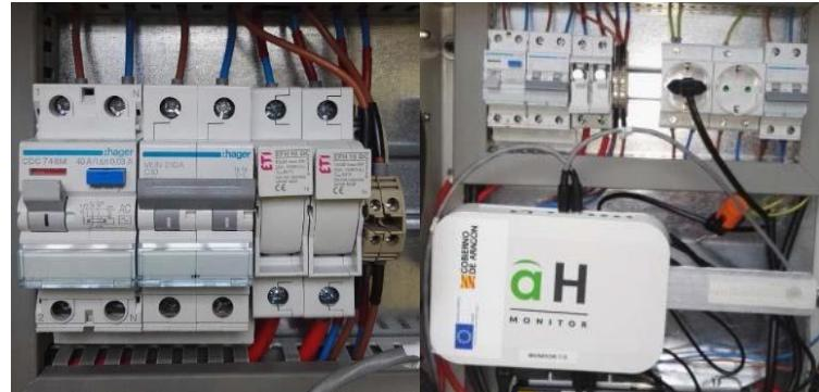
Figura 17: Detalle de protecciones y dispositivo de monitorización [1].
