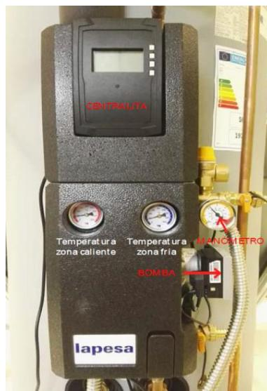
Figura 11: Detalle del equipo de bombeo [1].
