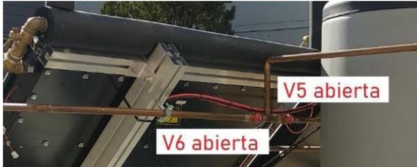
Figura 19: Detalle válvulas 5 y 6 [1].
