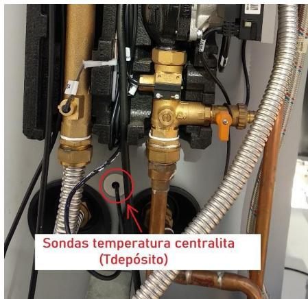
Figura 16: Detalle de situación de las sondas [1].
