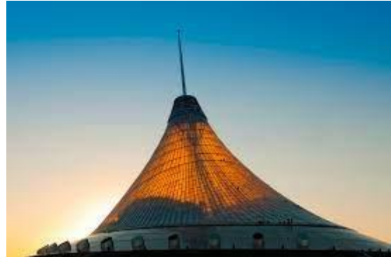
Fig. 16 Geometria anticlastica formada por cojinetes. Khan shatyr, Astaná, Kazajistán.
