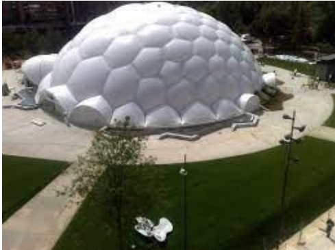
Fig. 17 Geometria sinclastica formada por cojinetes. Cupula del Milenio, Valladolid.
