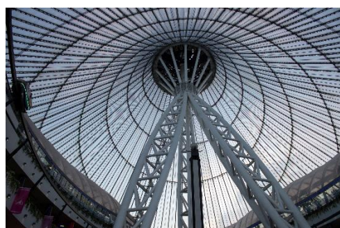
Fig. 25 Union del trípode al anillo superior de la envolvente.
