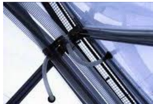
Fig. 19 Sistema inflado en los cojinetes, Conductos de regulación de presión.
