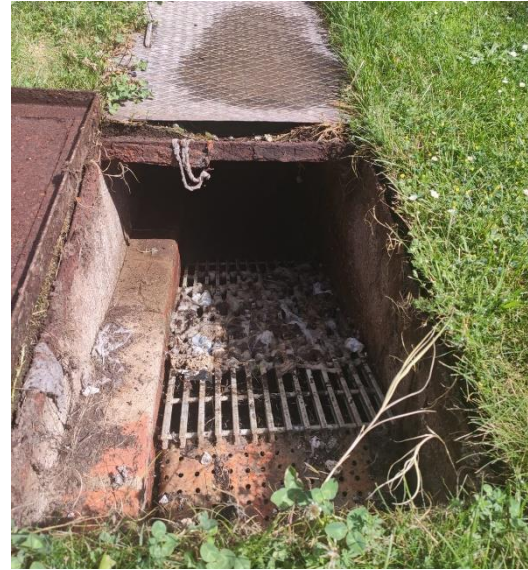
Figura 10. Rejas para desbaste. Fuente: EPSH
