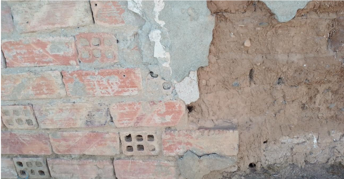
Fig. 29 Textura del ladrillo de las viviendas de El Temple. Unión de vivienda original de ladrillo con ampliación de adobe. Fuente: Imagen personal.
