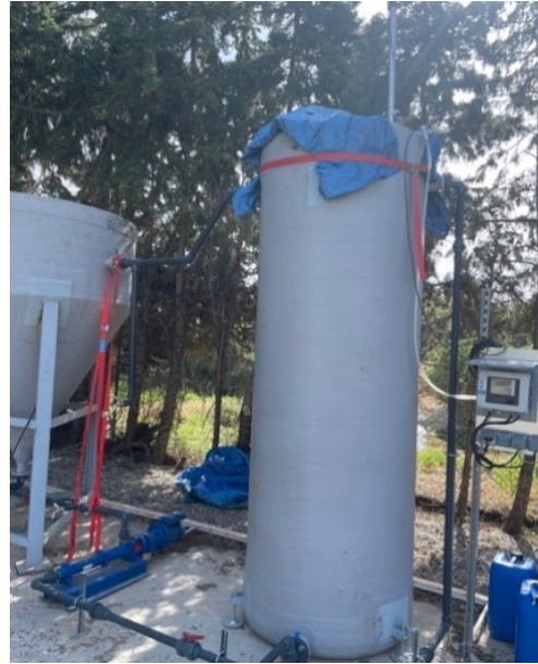
Ilustración 5. Reactor biológico
