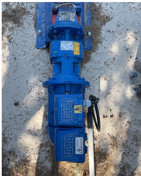
Ilustración 10. Bomba para impulsar el agua residual
