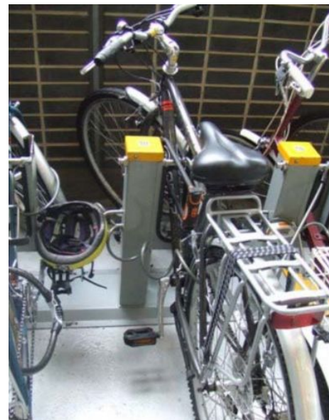
Figura 118. Ejemplo de soporte con antirrobo incorporado. Fuente: Manual de aparcamiento de bicicletas.
