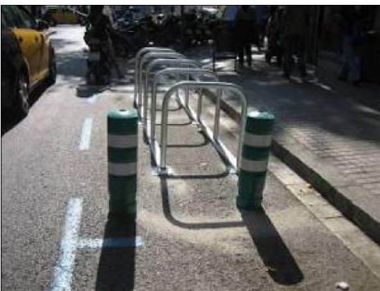
Figura 122. Bolardos protegiendo un aparcabicis.. Fuente: Manual de aparcamiento de bicicletas.
