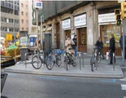
Figura 121. Aparcabicis sobre plataforma de hormigón. Fuente: Manual de aparcamiento de bicicletas.
