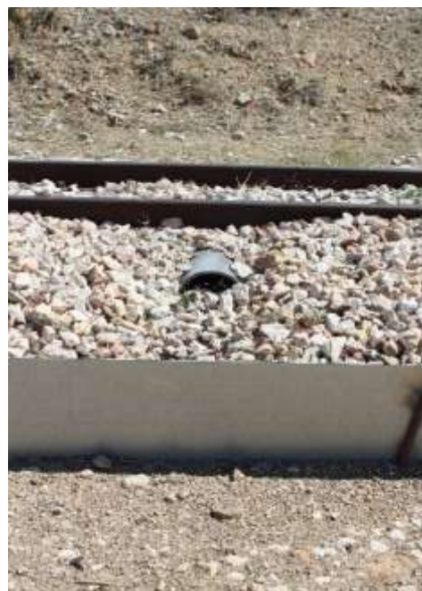
Ilustración 8.- Tubo de drenaje de PVC cegado y con un tablero que trata de contener el balasto para no perder la forma
