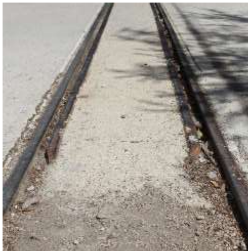
Ilustración 7.-Estado actual de la vía en placa
