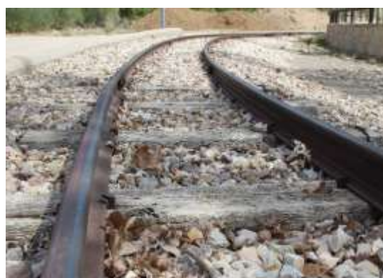
Ilustración 5.-Plataforma, carril y traviesas de madera
