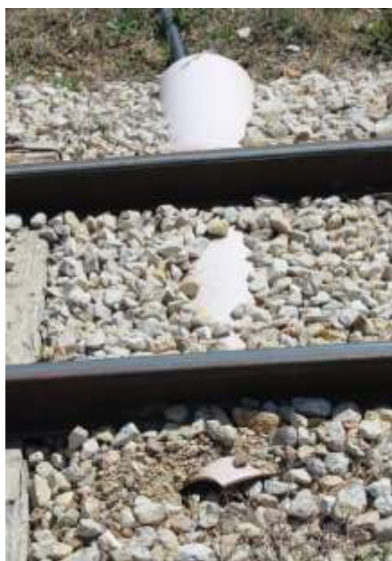
Ilustración 6.-Tubo de drenaje de PVC cegado al completo y con una tubería de riego por goteo que lo atraviesa
