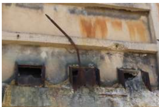
Ilustración 29.-Tolva y piqueras para cargar los vagones del ferrocarril
