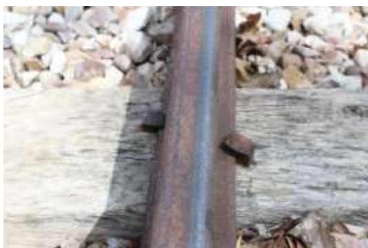
Ilustración 10.-Método de sujeción entre carril y traviesa
