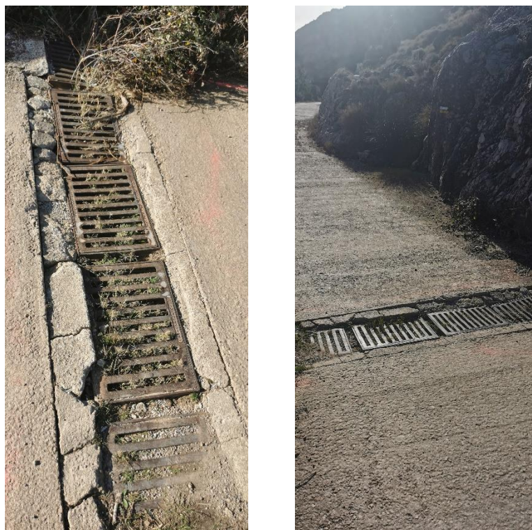
Ilustración 12.-Drenaje transversal actual en el segundo tramo
