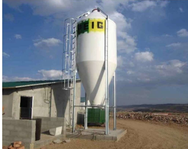
Ilustración 28: Silo de poliéster (Fibra de vidrio).
