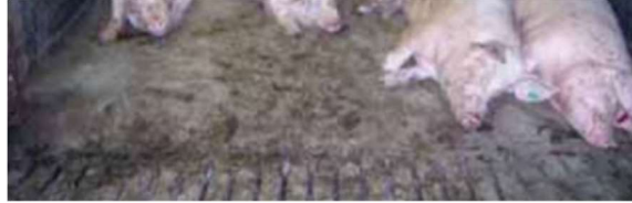
Ilustración 11: Solado parcialmente con slats.
