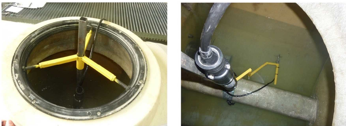
Figura 23. Elementos auxiliares necesarios para llevar a cabo mediciones en un depósito de pulverizador hidroneumático.
