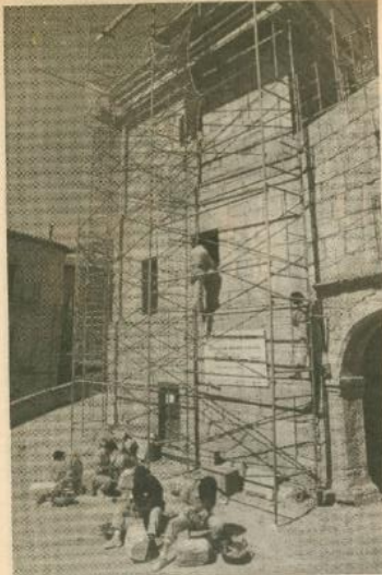
La restauración del Torreón Medieval del siglo XIII es uno de los trabajos que se realizan en la Escuela Taller.
