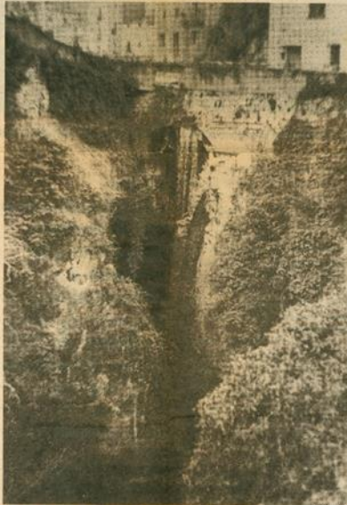
ALGUNAS OBRAS DE REHABILITACION, ACOMETIDAS POR LOS PROPIOS VECINOS, SON REALMENTE IMPORTANTES.
