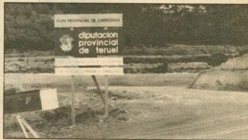
Obras de la carretera Castellote-Venta de la Pintada
