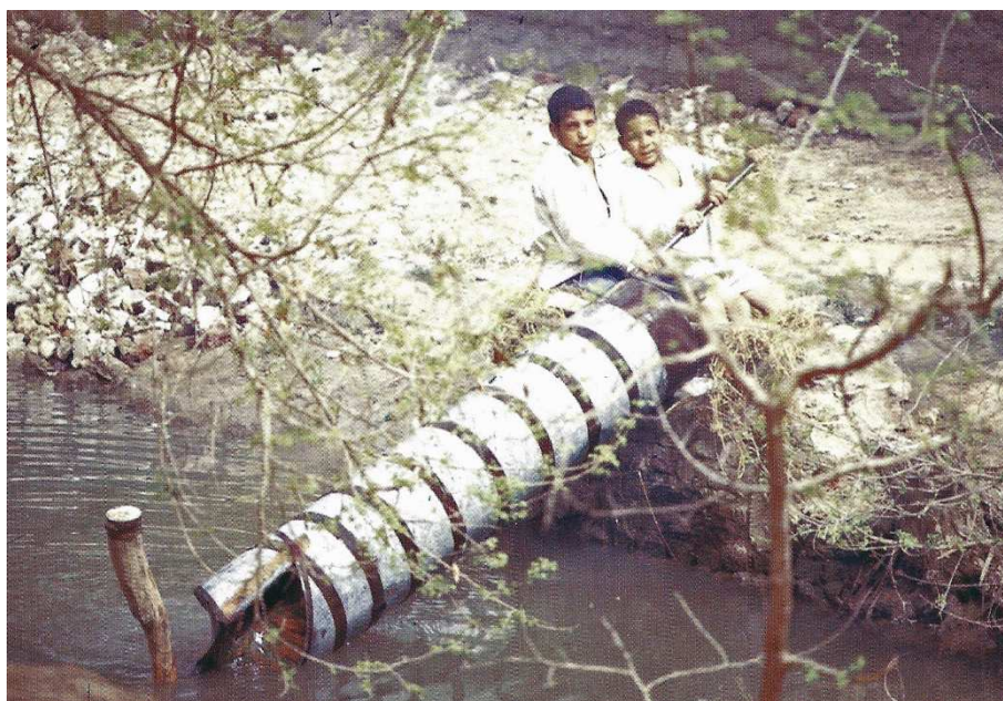
Fig. 152. Fotografía que muestra la utilización del tornillo de Arquímedes en Fayum en los años 70 (Hairy, 2011: 561, fig. 8).
