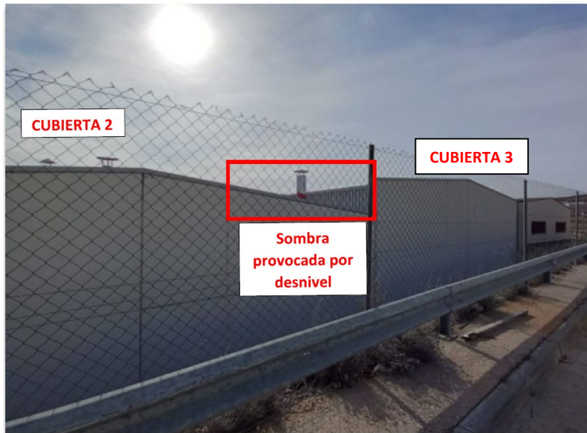
Imagen 6. Cubiertas a diferentes alturas
