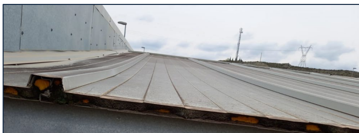
Imagen 13. Espesor de la cubierta de la nave
