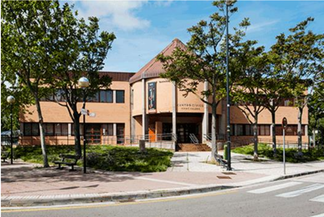
Ilustración 3 Centro Cívico Isaac Valero. Fuente: Ayuntamiento de Zaragoza.
