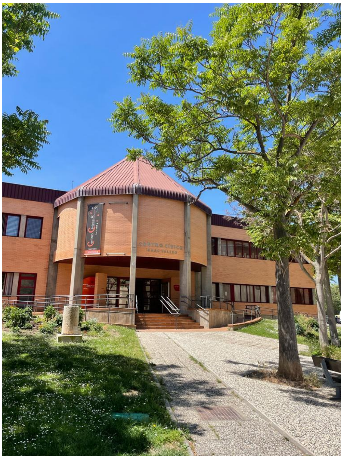
Ilustración 39 Centro Cívico Isaac Valero. Fuente: EP.
