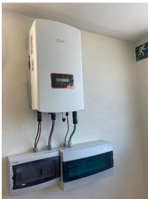
Ilustración 33 Inversor solar. Fuente: EP.
