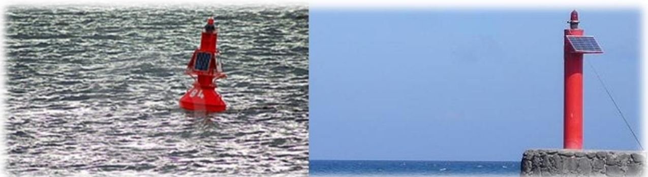
Figura 9. Aplicaciones de la energía fotovoltaica para iluminación en el ámbito de la navegación
