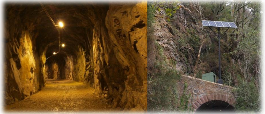
Figura 8. Túnel iluminado con tecnología fotovoltaica en Navarra, España.
