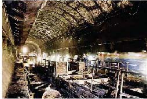
Daños en un túnel después del incendio de una tuneladora
