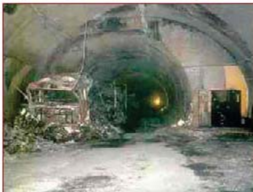
Daños en el túnel del Mont Blanc después del incendio
