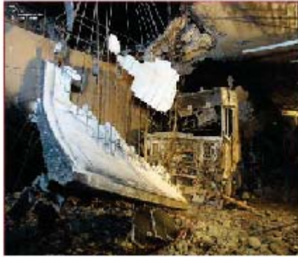
Elementos caídos en el túnel de San Gotardo después del incendio
