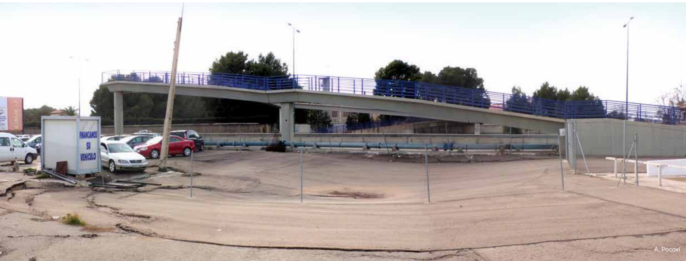
Figura 1: deformaciones causadas por el hundimiento continuado de una dolina situada en las inmediaciones del km 246 de la N-232. En la zona del aparcamiento se aprecia una depresión superficial, escalones en el asfalto y el basculamiento de un pilar. En este lugar se ha tenido que reparar frecuentemente la tubería de abastecimiento de agua al barrio de Casetas.
