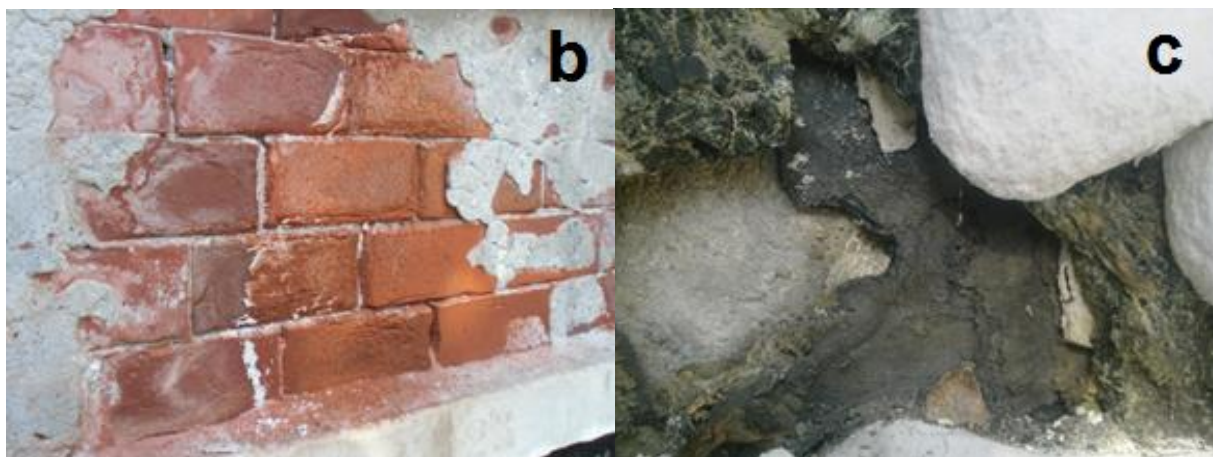
Figura 7. a) Perfil con los morteros utilizados detrás de las lastras. b) Pared de ladrillos con restos de un revoco superficial formado por mortero de cal y yeso (9_125(/)). c) Hueco en la lastra de oficalcita 7_97(1907) en el que se observa el mortero de cal y yeso que cubre los ladrillos, la capa de arcilla y el mortero de yeso detrás de la oficalcita.
