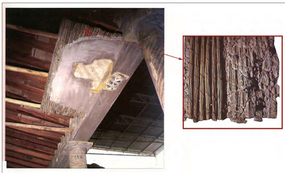
Fig. 14. Techo con cañas como sistema de sujeción del enlucido en Oplontis (fotos de C. Guiral).
