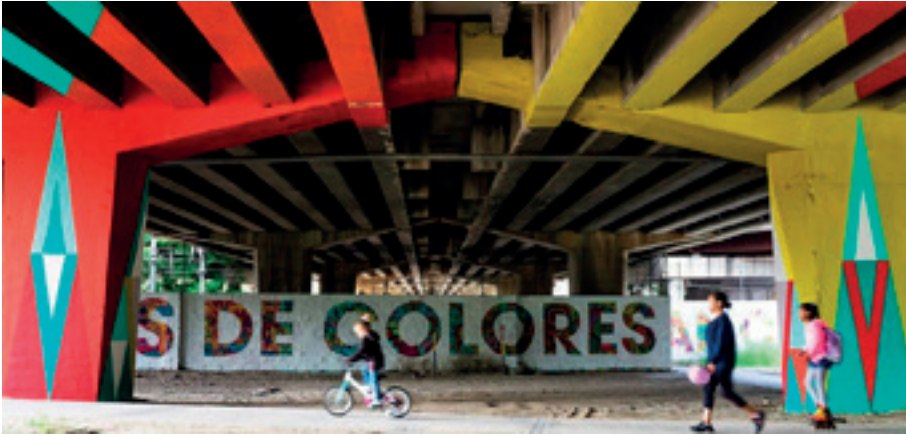
Fig. 9. Recuperación de un espacio abandonado en el barrio de San Cristóbal de los Ángeles, Madrid, , 2016, intervención de Basurama y Boa Mistura.
