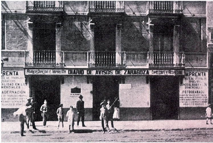
Fig. 1. Sede del Diario de Avisos de Zaragoza en el Coso, n.º 100, 1917.
