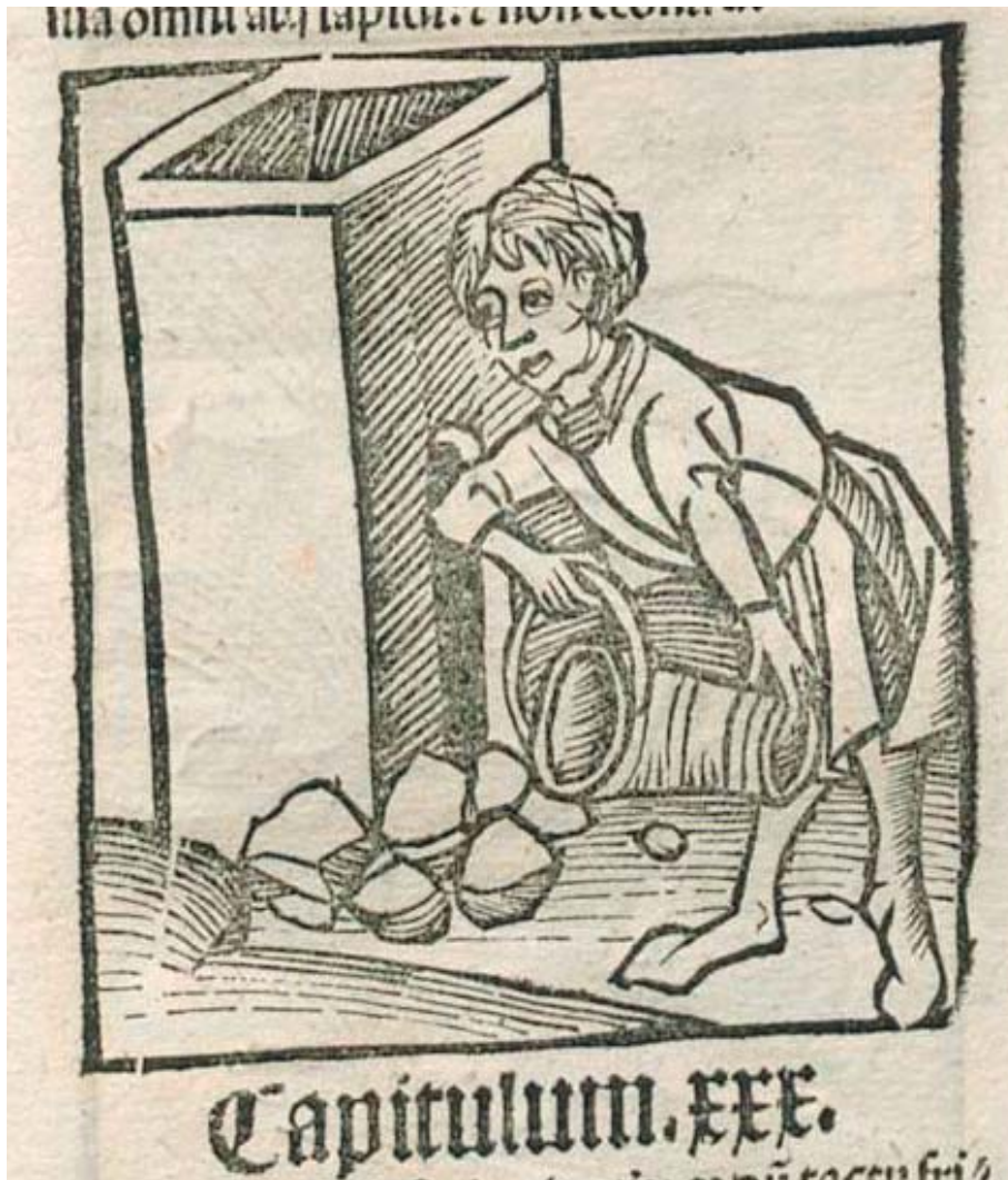
Grabado del Hortus sanitatis correspondiente al capítulo de la Cal, donde se aprecia el sistema de obtención de cal por medio de la combustión del carbonato de calcio en un horno.
