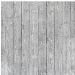
R1 Hormigón con acabado de encofrado visto
